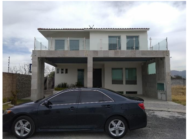
Autor: Bismarck Cruz Venegas Término de obra, Villa Molino de Flores, Texcoco
