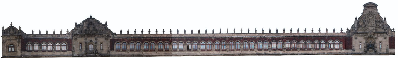
Ilustración 5. Larguillo fotográfico del tercer piso de la fachada poniente del Palacio Nacional. Ortoimagen renderizada en programa PhotoScan
