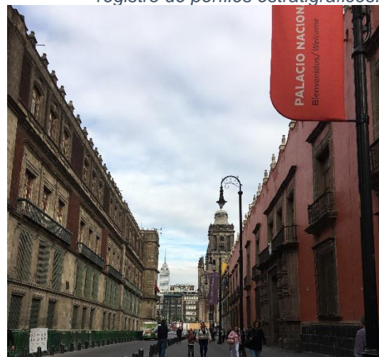
Ilustración 10. Calle de Moneda, antes de los trabajos de rehabilitación.
