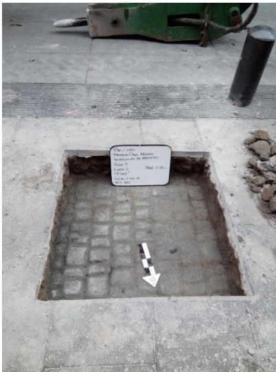
Ilustración 7. Fotografía de primera capa de la excavación. Estampado de concreto.
