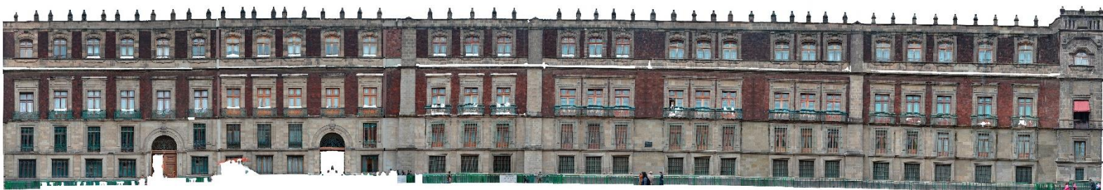
Ilustración 4. Larguillo fotográfico la fachada norte de Palacio Nacional. Ortoimagen renderizada en programa PhotoScan.
