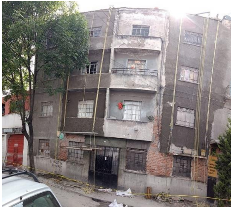
Imagen 3. Reporte fotográfico de avance de aplicado de repello, Colonia Guerrero, CDMX.
