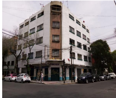
Imagen 3. Reporte fotográfico de avance de aplicado de pintura, Colonia Guerrero, CDMX.
