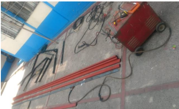
Imagen 1. Supervisión de obra interna, unidad habitacional Manuel M. López III, Tláhuac, CDMX.
