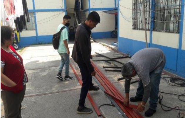
Imagen 1. Supervisión de obra interna, unidad habitacional Manuel M. López III, Tláhuac, CDMX.
