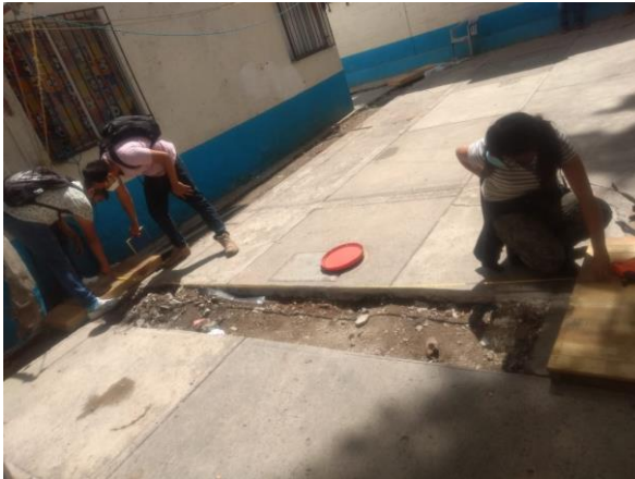
Imagen 2. Supervisión de obra externa, unidad habitacional Ixnahualtongo 20-22, Venustiano Carranza, CDMX.
