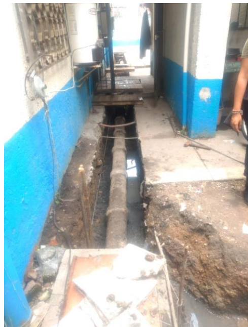
Imagen 2. Reporte fotográfico del avance, unidad habitacional Ixnahualtongo 20-22, Venustiano Carranza, CDMX.
