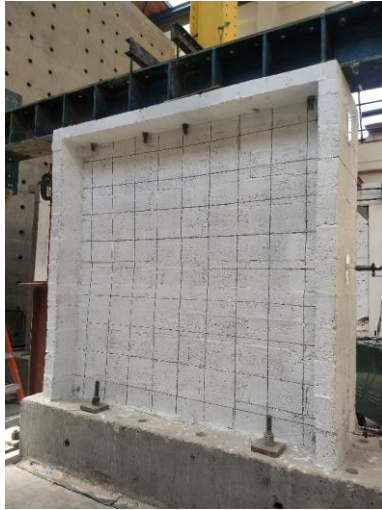
Figura 2: Colocación de anclaje a losa de reacción y de viga en la losa del muro
