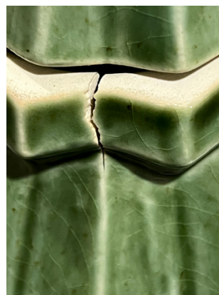
Figura 12. Pieza agrietada del vertedero y esmalte craquelado
