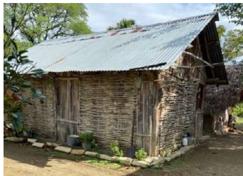
Figura 6. Casa de bajareque con basamento de tierra y rocas calizas, Ocampo, Tamaulipas.
