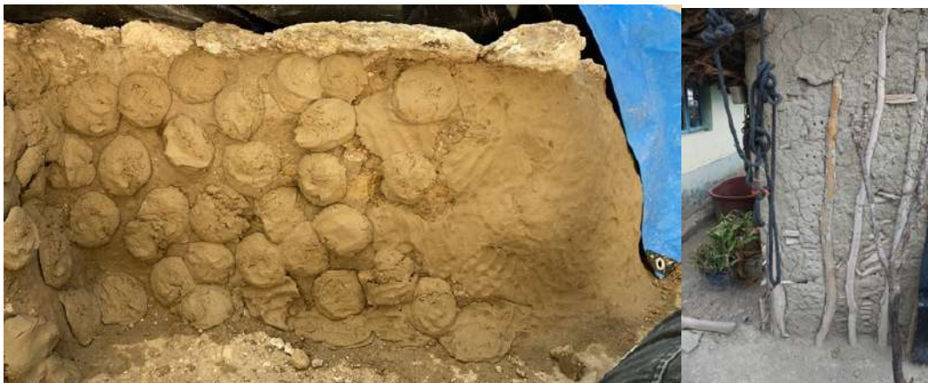
Figura 35. Aplicación de la Capa de sacrificio I (izquierda). Casa de bajareque en donde el barro se aplicó con la técnica de barro modelado.
