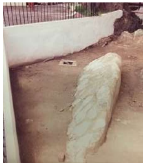
Figura 24. Talud I, sección oeste recién restaurado. Al fondo se observa al higuerón sobre la escalinata I, II y III. (Acervo fotográfico CITAM).
