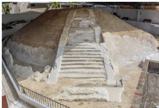
Figura 25. Foto del "Basamento A" casi a la conclusión de los trabajos del 2021.
