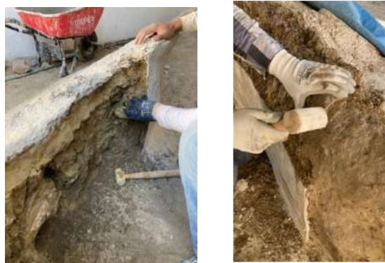
Figura 34. compactación manual (izquierda) y mecánica de los rellenos consolidados (derecha).
