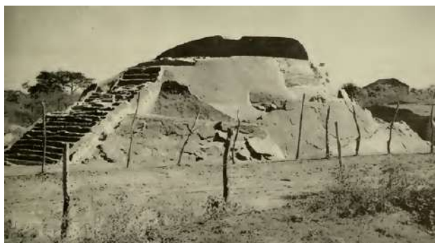
Figura 21. Edificio consolidado al final del proyecto. (Strong, 1943).
