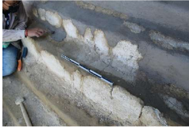
Figura 34. Aplicación de la Capa de Sacrificio II, en la escalinata.
