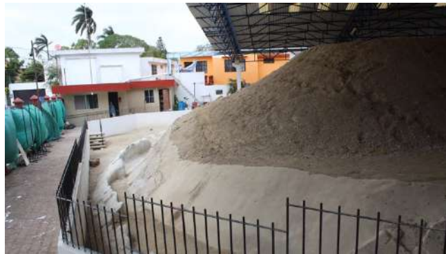
Figura 11. Vista hacia el norte en donde se pueden ver las casas aledañas. También se observa el espacio faltante de la techumbre, poco antes de concluir con la intervención y que se techara.
