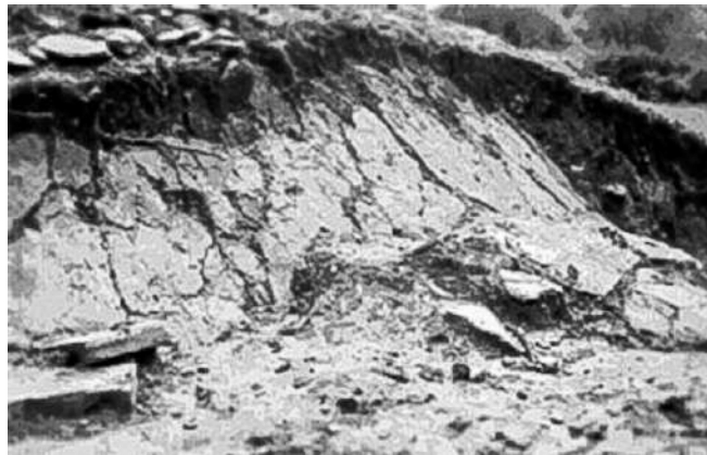
Figura 20. Detalle de una capa de argamasa que reviste a los taludes al momento de su excavación. (Mediateca INAH).
