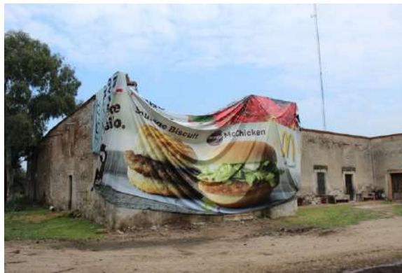
Figura 2. Casco de hacienda en Lagos de Moreno, Jalisco. Al interior se observa una antena de telecomunicaciones.
