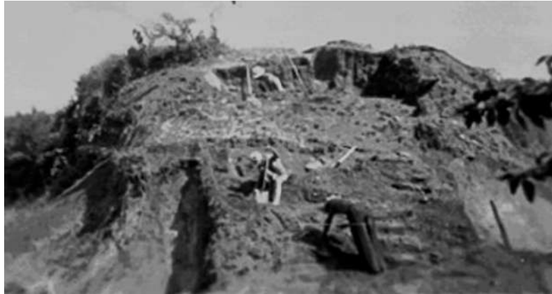
Figura 18. Detalle de la excavación de la escalinata. (Mediateca INAH).
