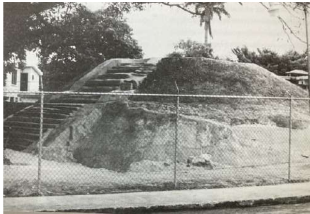
Figura 23. Vista del sitio casi al final de los trabajos de 1991. En la parte superior izquierda se observan las ramas y hojas del higuierón. (Mediateca INAH).
