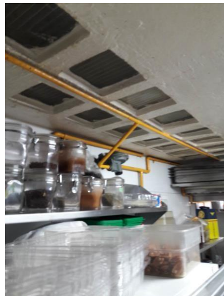
Fuente: Fotografía propia Acercamiento a instalaciones de gas, interior de cocina
