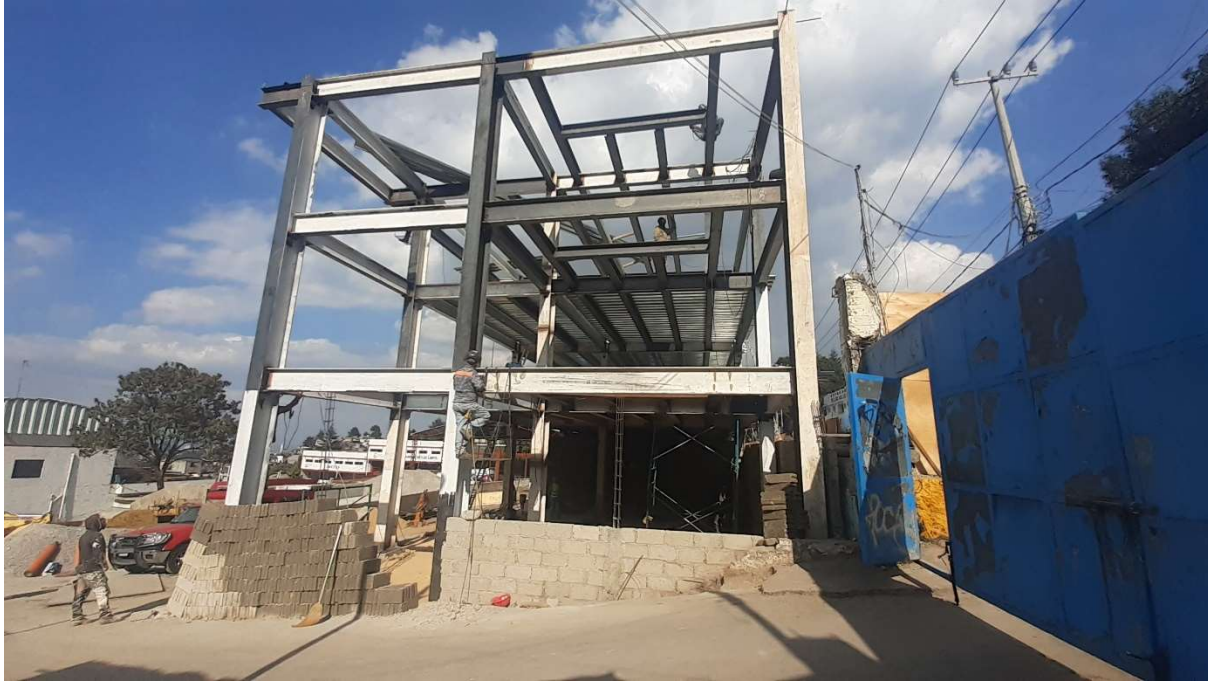
Visita de obra del día 02 de Diciembre de 2020, tendido y colocación de losacero.
