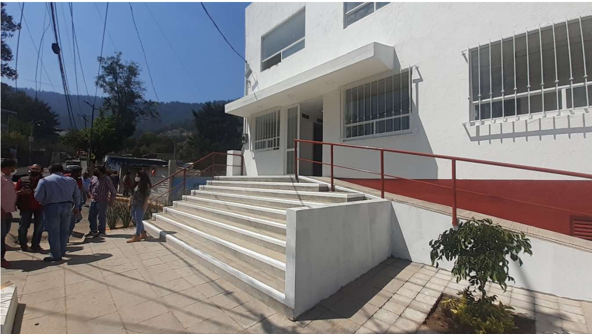
Visita de obra del día 26 de Febrero de 2021, fachada principal.
