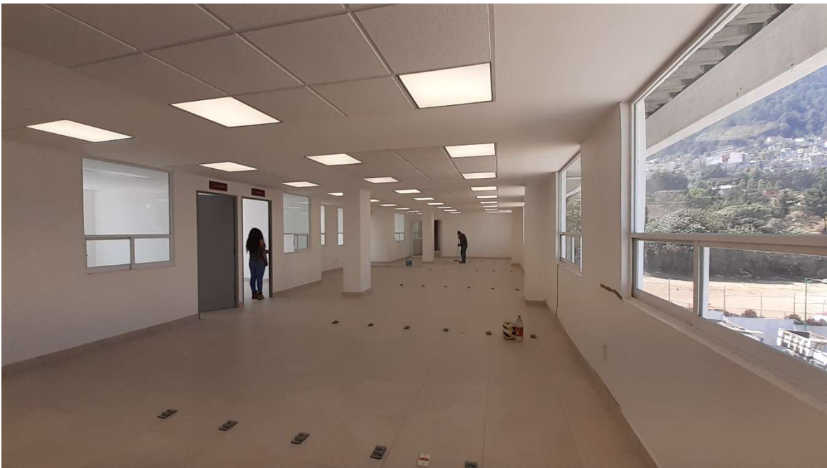
Visita de obra del día 26 de Febrero de 2021, planta segundo nivel
