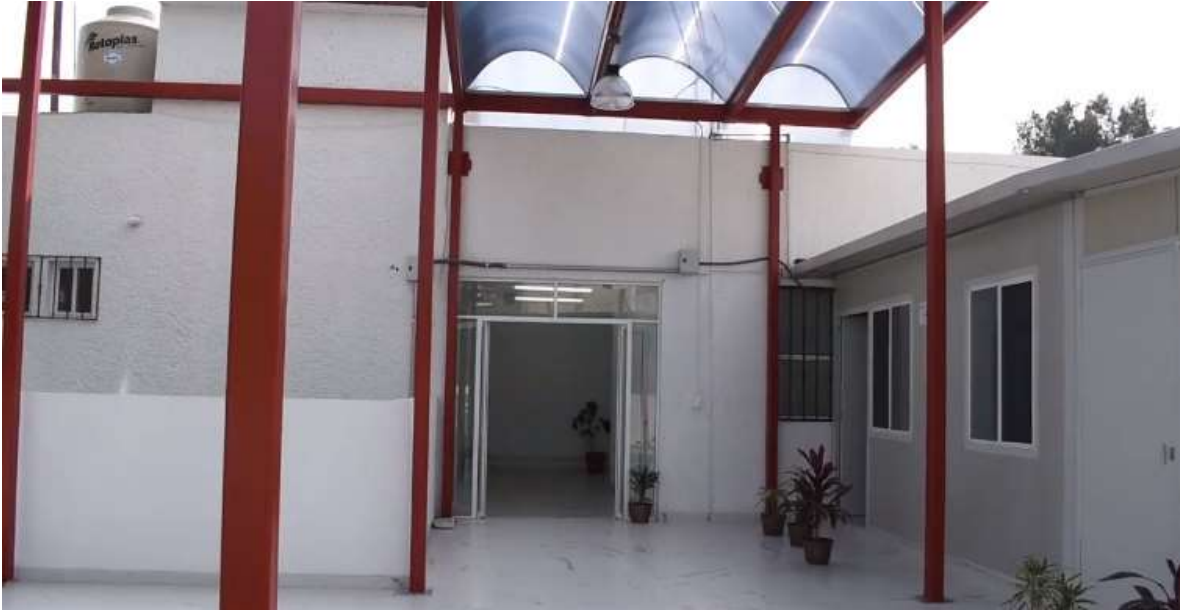
Visita de obra del día 28 de Enero de 2021, terraza en planta azotea
