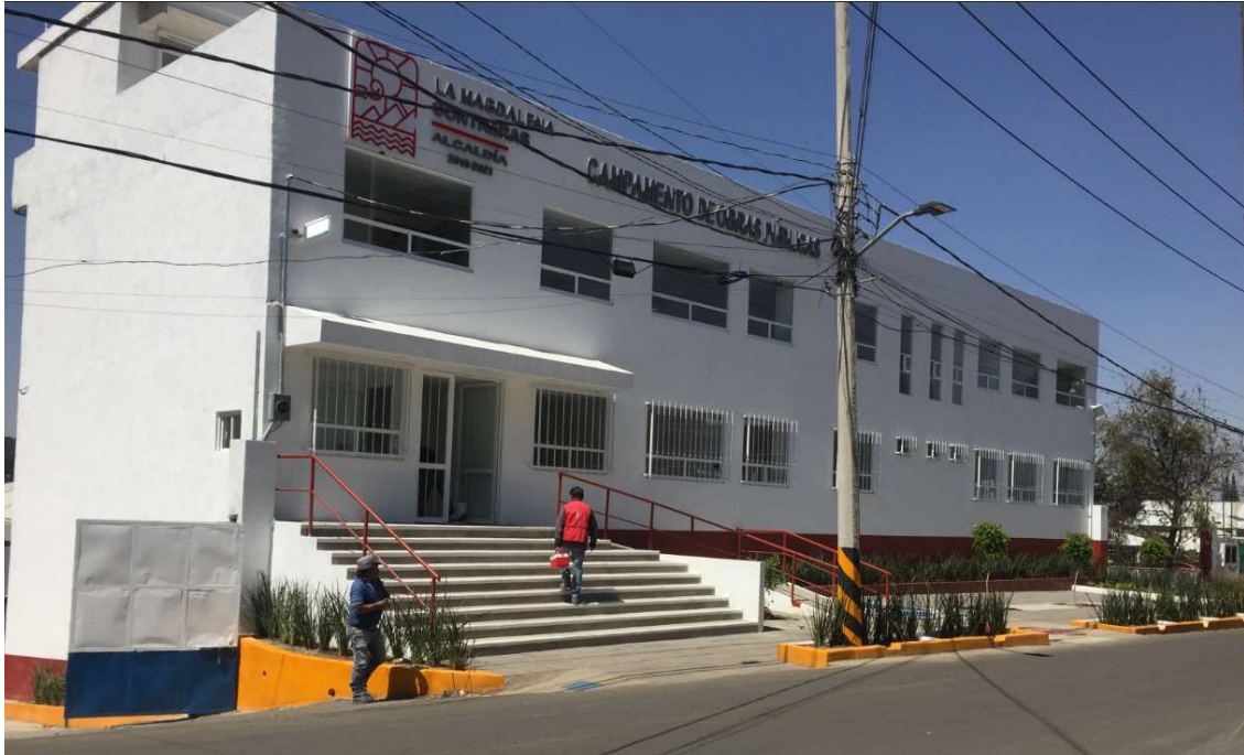
Visita de obra del día 07 de Mayo de 2021, fachada principal (termino de obra)
