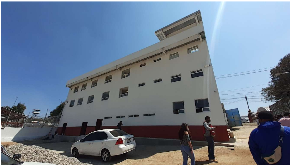
Visita de obra del día 26 de Febrero de 2021, fachada posterior.
