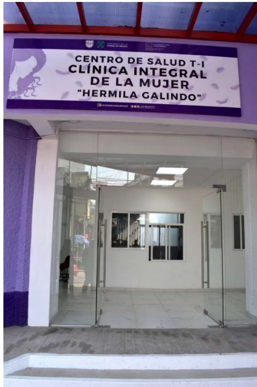
Visita de obra del día 28 de Enero de 2021, Acceso principal (termino de obra)
