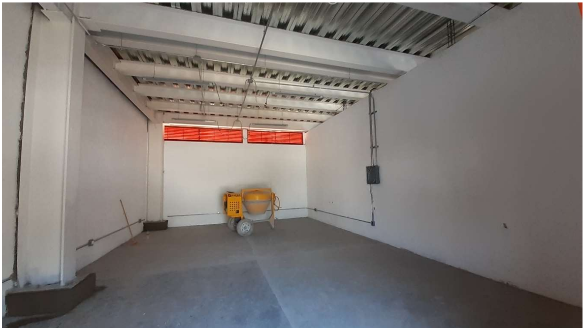
Visita de obra del día 26 de Febrero de 2021, planta sótano (taller de herrería)
