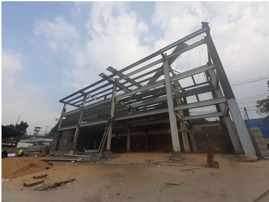
Visita de obra del día 30 de Noviembre de 2020, montaje de estructura.
