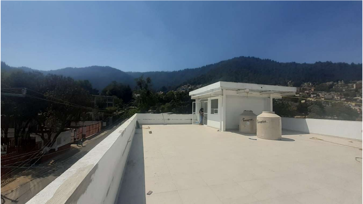
Visita de obra del día 26 de Febrero de 2021, planta azotea
