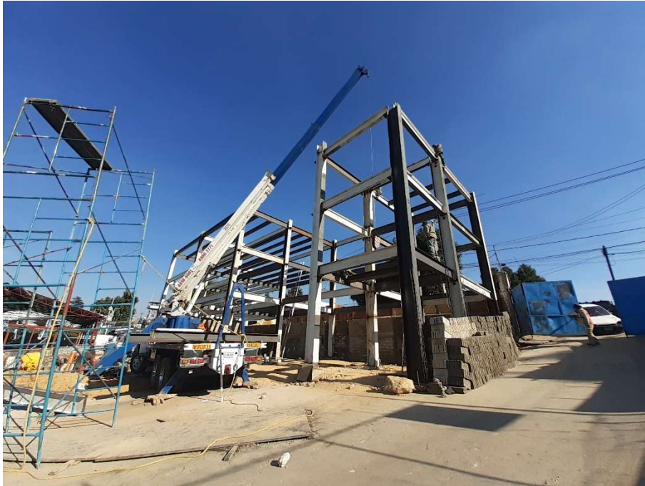
Visita de obra del día 26 de Noviembre de 2020, montaje de estructura.
