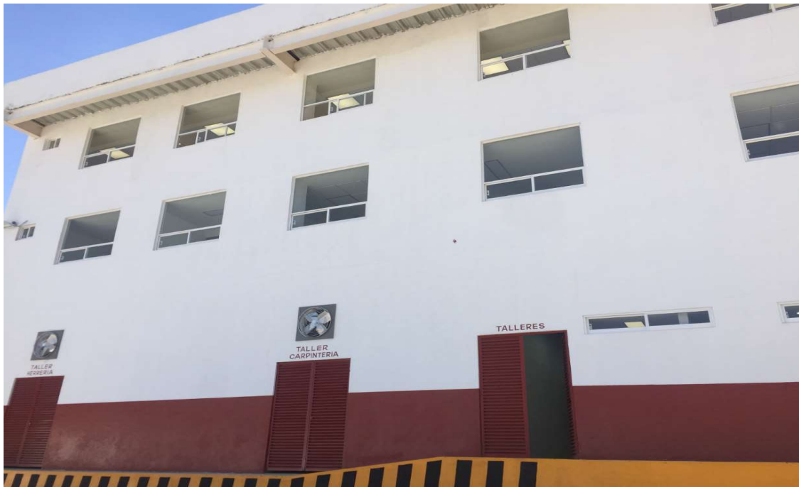
Visita de obra del día 07 de Mayo de 2021, fachada posterior (termino de obra)
