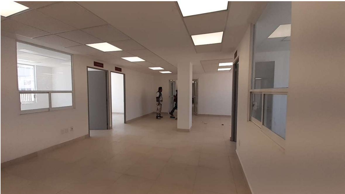
Visita de obra del día 26 de Febrero de 2021, planta primer nivel
