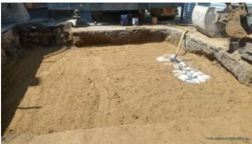
Imagen 7. Piso ya con relleno en la estación San Lázaro
