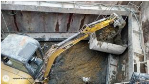
Imagen 5. Excavación en los cárcamos de la estación San Lázaro
