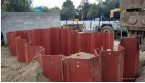
Imagen 2. Colocación de pilotes en las instalaciones de la estación Zaragoza
