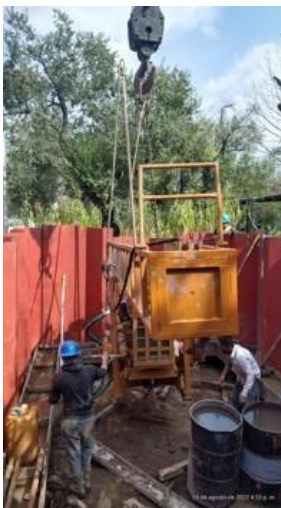
Imagen 1. Colocación de pilotes en las instalaciones de la estación Zaragoza
