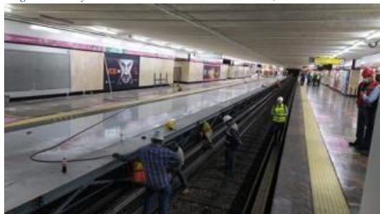
Imagen 8. Cierre provisional en la estación Balderas debido a las remodelaciones en toda la línea 1
