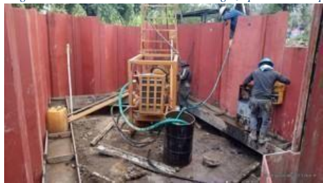
Imagen 4. Excavación en estación Zaragoza para colocar pilotes nuevos
