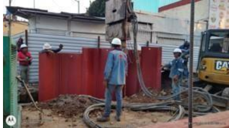
Imagen 3. Excavación en estación de Zaragoza para colocar pilotes nuevos
