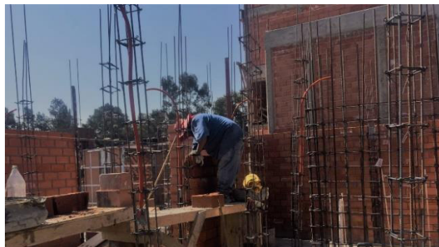
Figura 5. Continuación del enrase de muros. Fuente: Aguilar, A. (2023)
