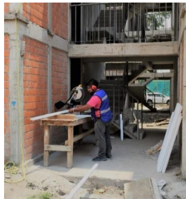
Figura 3. Continuación de trabajos de cancelería. Fuente: Aguilar, A. (2023)
