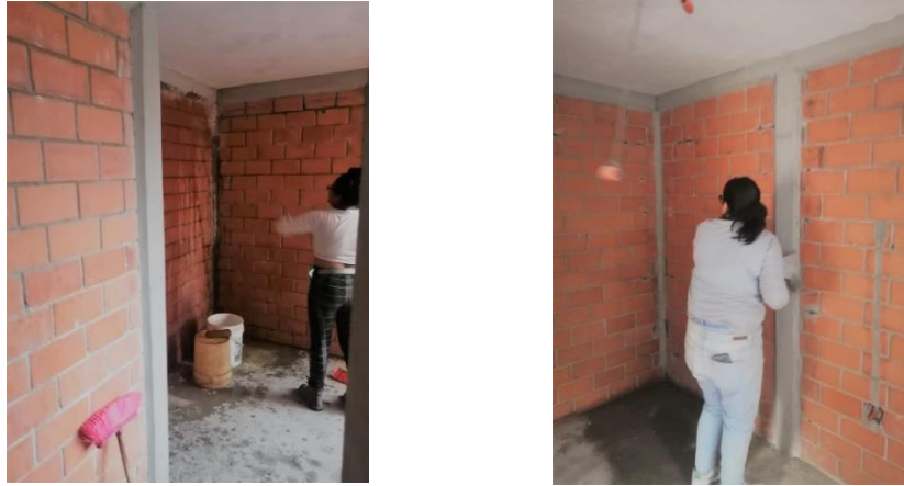
Figura 9. Lavado de muros. Fuente: Aguilar, A. (2023)
