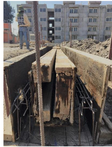
Figura 20. Encofrado de armados en rejillas de agua pluvial. Fuente: Aguilar, A. (2023)
