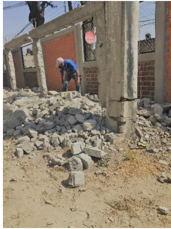
Figura 19. Demolición de antigua barda perimetral. Fuente: Aguilar. (2023)
