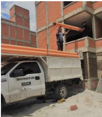
Figura 2. Descarga de material (Tubos de pvc). Fuente: Aguilar, A. (2023)
