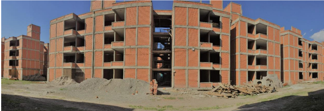
Figura 1. Obra Habitacional "Mz 25" Fachada del Frente Sur. Fuente: Aguilar, A. (2023)
