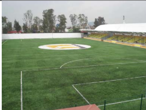
Fotografía tomada durante la visita a obra. Resultado final de la obra
