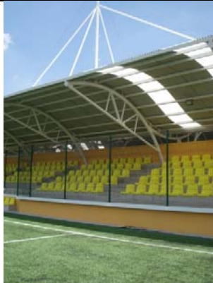
Fotografía tomada durante la visita a obra. Resultado final de la obra
