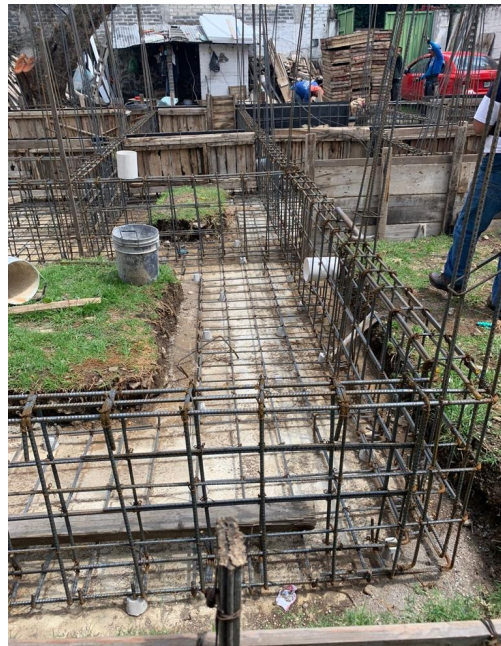
Fig.6. Excavación y armado para zapatas corridas de cimentación, en proceso de cimbra para su colado.
