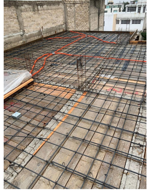
Fig.5. Armado y cimbra para colado de losa. Se observó orden y precisión en los armados y amarres, así como en los tableros de la cimbra.
