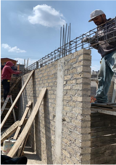
Fig. 1. Supervisión de de armados de cadenas. Esta obra se realizó en perfectas condiciones, orden y limpieza, así como sus armados, fueron elaborados con base a las instrucciones del plano estructural.
