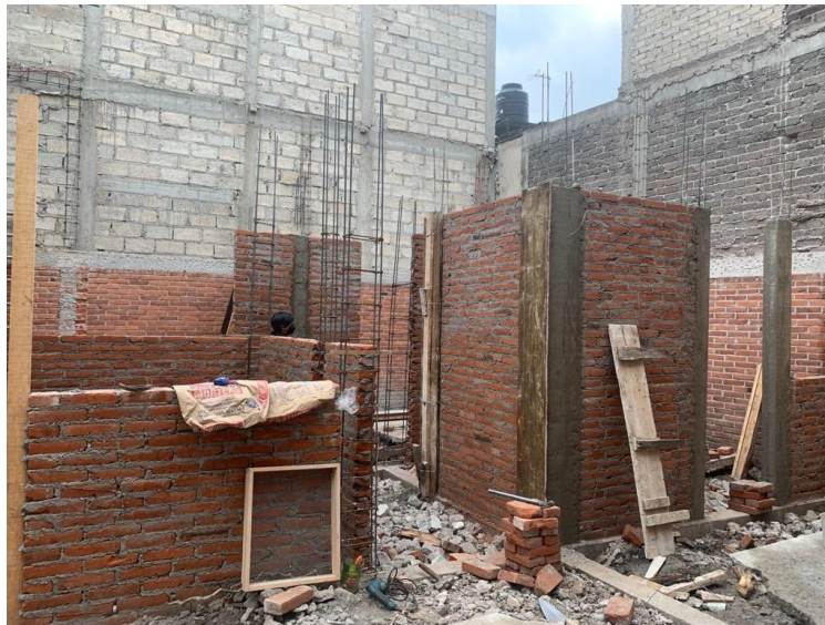
Fig. 3. Supervisión de obra, levantamiento de muros y castillos. Esta obra se realizó con la recuperación de tabique rojo recocido, con la finalidad de disminuir costos.
