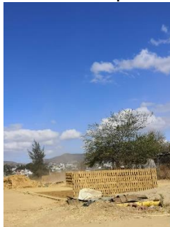
Depósitos de materiales
