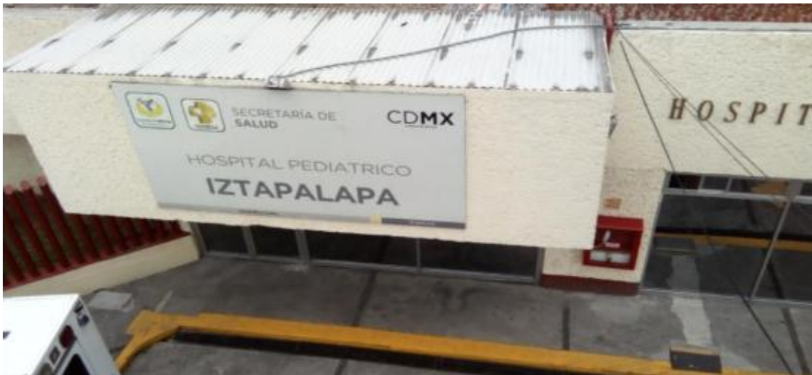
Figura 4. Vista desde arriba del Hospital Pediátrico Iztapalapa
