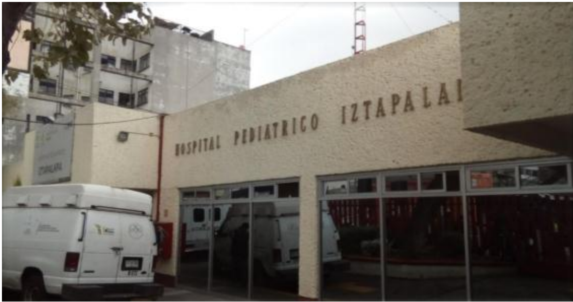
Figura 3. Entrada principal del Hospital Pediátrico Iztapalapa
