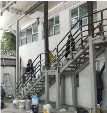
Ilustración 19 Construcción de escalera.
