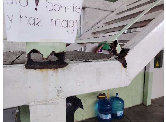
Ilustración 15 Fotografía escalera. Toma propia.
