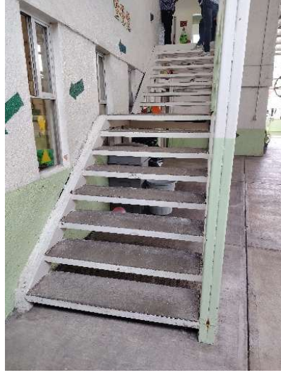
Ilustración 14. Fotografía escalera. Toma propia.
