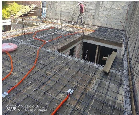
*Imagen 3.1 Armado de Losa, 2023*
