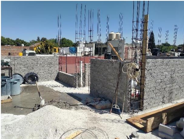
*Imagen 2.1 Levantamiento de muros / Colado de castillos, 2023*
