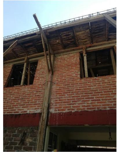
*Imagen 3.4 Cimbrado para Losa, 2023*
