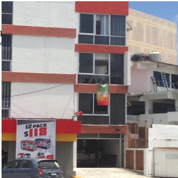
Fotografía 2. Fachada del edificio IMJUVE
