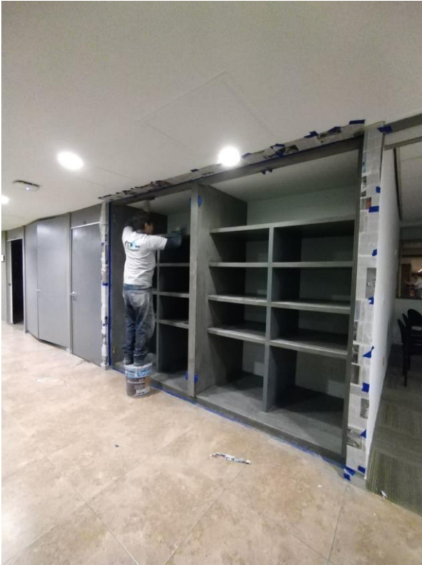
Imagen 5: Coordinacion de trabajos de carpinteria en manetimiento correctivo de archiveros altos de madera.
