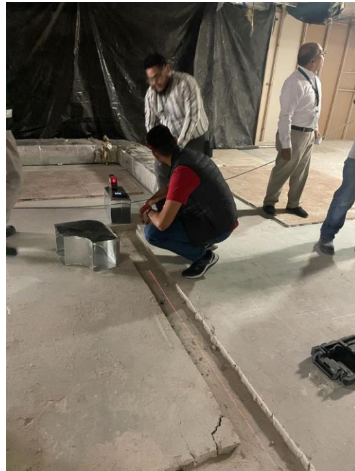
Imagen 2: Coordinación de Trazo en losa para canalizar instalaciones electricas y de voz y datos en los trabajos de adecuacion para el desarrollo del proyecto TSN5 – R.H.
