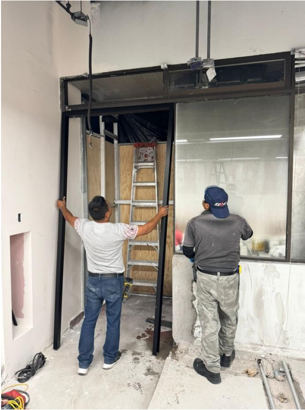
Imagen 3: Coordinación de canalización de puerta de acceso en los trabajos de adecuación para el desarrollo del proyecto TSN33 – Biblioteca CNBV - Comisión Nacional Bancaria y de Valores, CDMX.
