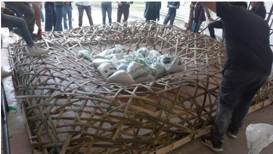
Taller de sistemas alternativos con Bambú (Colapso de estructura 2).
