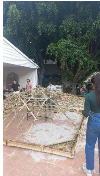
Taller de sistemas alternativos con Bambú (armado estructura 1).
