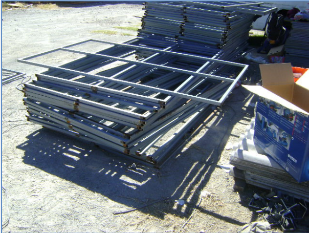
Fabricación de estructura.
