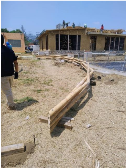
Imagen 26: Colocación de arco para levantamiento “Taller de sistemas estructurales con bambú.”
