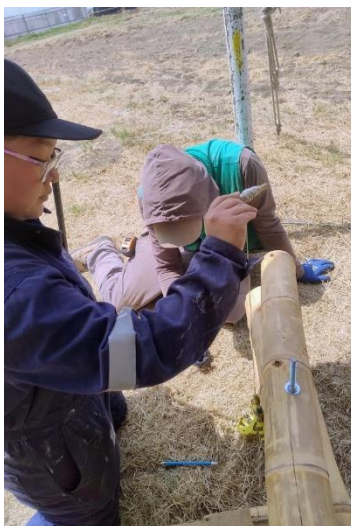
Imagen 24: Medida con nivel de base de arco “Taller de sistemas estructurales con bambú.”
