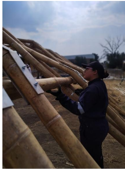
Imagen 26: Colocación de uniones entre arco y arco “Taller de sistemas estructurales con bambú.”
