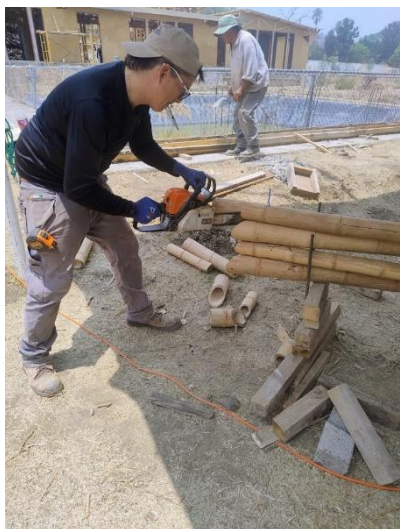
Imagen 23: Corte de sobrante de culmos base “Taller de sistemas estructurales con bambú.”
