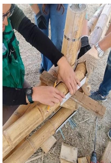
Imagen 22: Marcado de perforación para solera “Taller de sistemas estructurales con bambú.”
