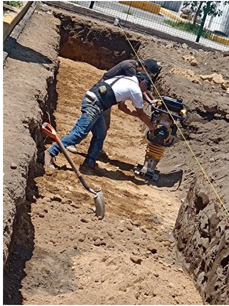
Mejoramiento y compactación de tepetate con cemento
