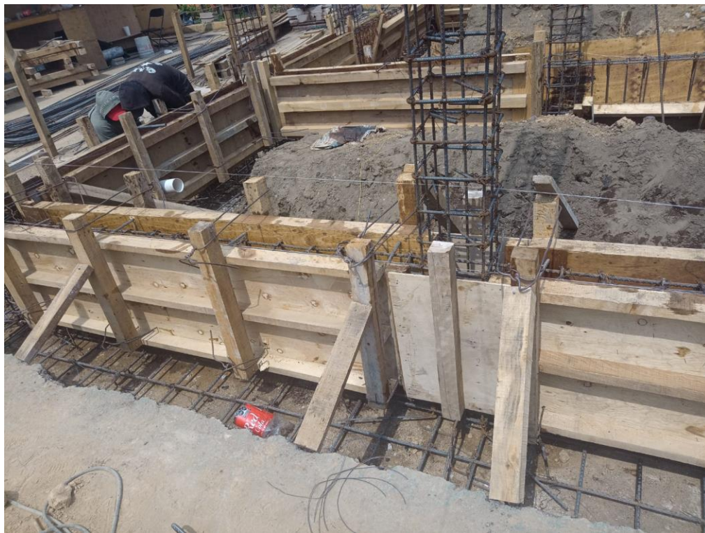
Colocación de cimbra
