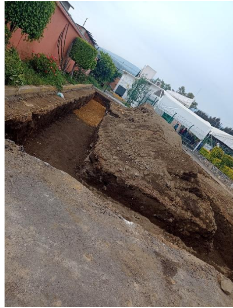
Mejoramiento y compactación de tepetate con cemento
