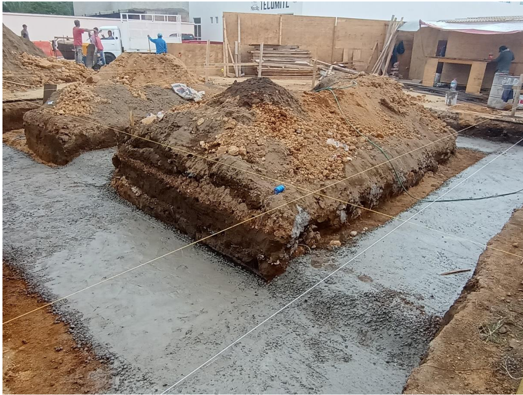
Plantilla de concreto hidráulico f'c = 100 \text{ kg/cm}^2 , de 5 cm de espesor
