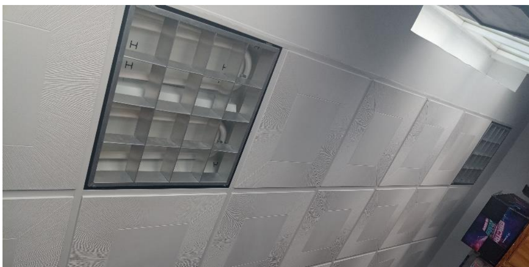
Cambio de luminarias
