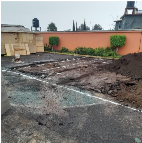
Trazo y excavación
