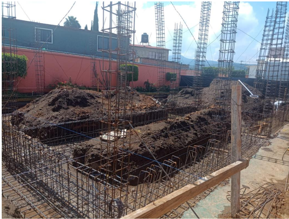
Armado de zapata corrida, contratrabes y columnas
