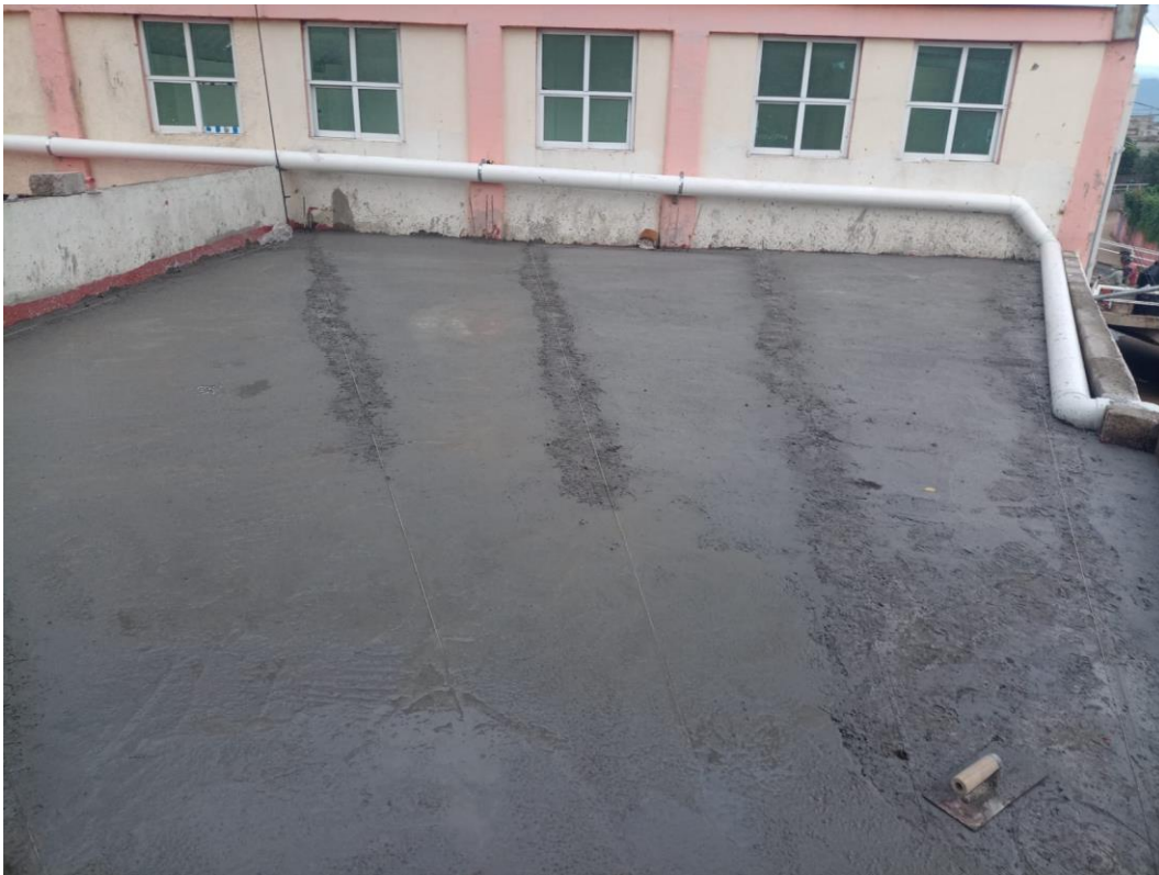
Entortado de concreto para dar la pendiente para el agua pluvial
