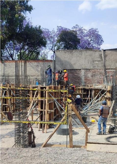
ANEXO 7 Mayeli Azcar, año 2024. Fotografía de colado de muro perimetral, columnas y muros de contención de estacionamiento en “La Cruz No.18” primera etapa.
