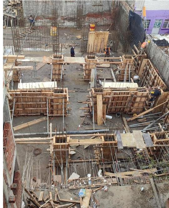
ANEXO 8. Mayeli Azcar, año 2024. Fotografía de colado de muro perimetral, columnas y muros de contención de estacionamiento en “La Cruz No.18” segunda etapa.
