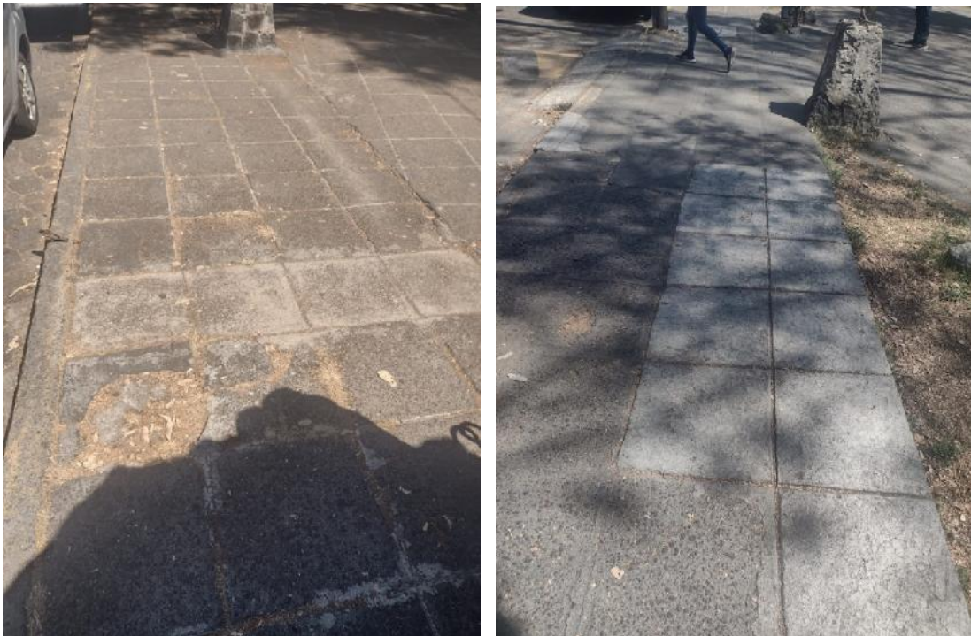
Imagen 16. Reparación de banqueta de piedra con concreto.
