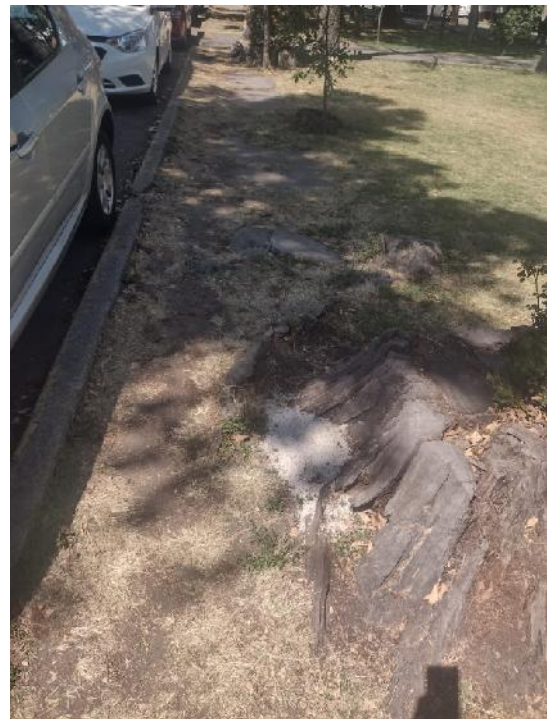
Imagen 14. Retiro de tocón de 1.00 y 1.50 m de diámetro. Fuente: Fotografía propia, febrero 2024-
