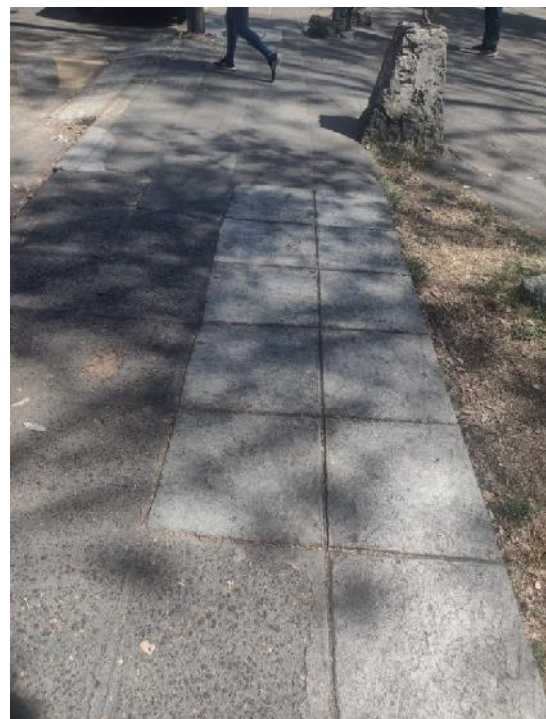
Imagen 18. Reparación de banqueta de piedra con concreto.
