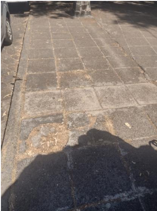
Imagen 18. Reparación de banqueta de piedra con concreto.
