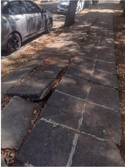
Imagen 17. Ruptura en banqueta por raíces de los árboles.
