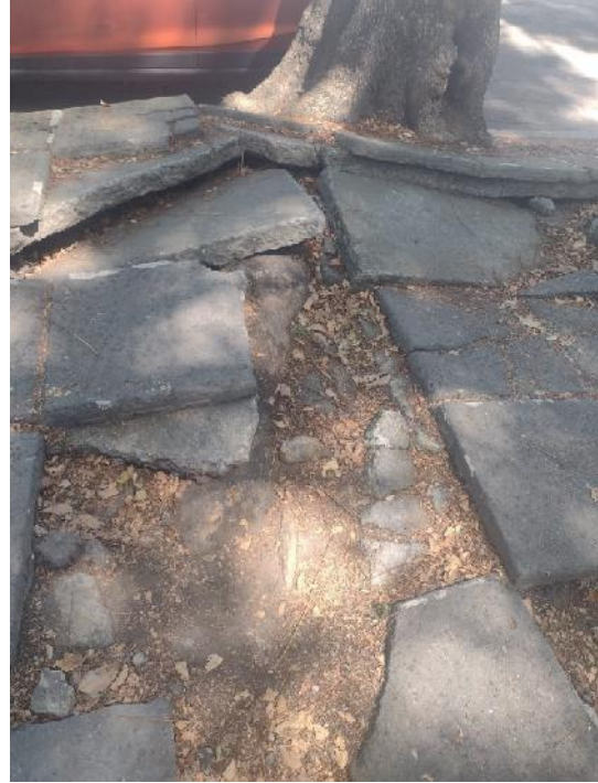
Imagen 17. Ruptura en banqueta por raíces de los árboles.
