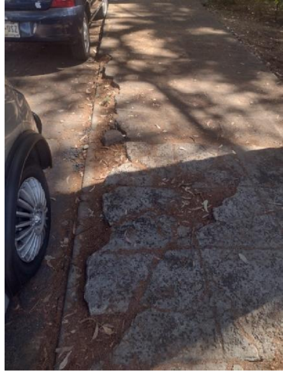
Imagen 13. Deterioro de guarnición y banqueta. Fuente: Fotografía propia, febrero 2024.
