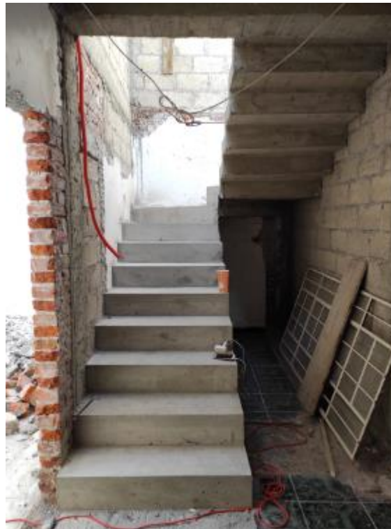
Imagen 20. Proyecto de remodelación en alcaldía Tlalpan, caso Socorro Gudiño. Acceso Segundo nivel.
