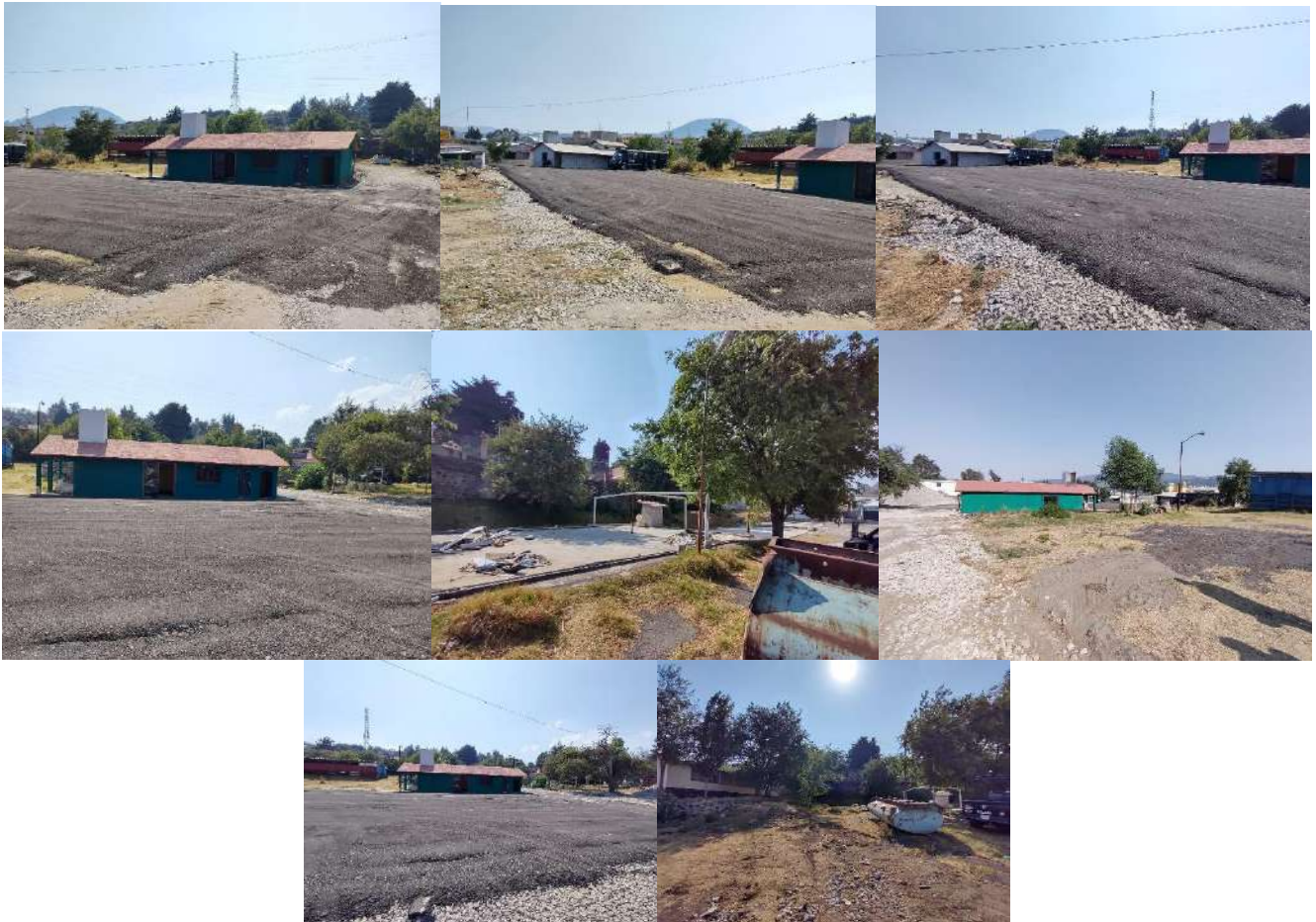
Estas fotografías muestran las condiciones del terreno ya con una nivelación adecuada del espacio, como el mantenimiento estético de las construcciones. Fotos de Luis Leonardo
