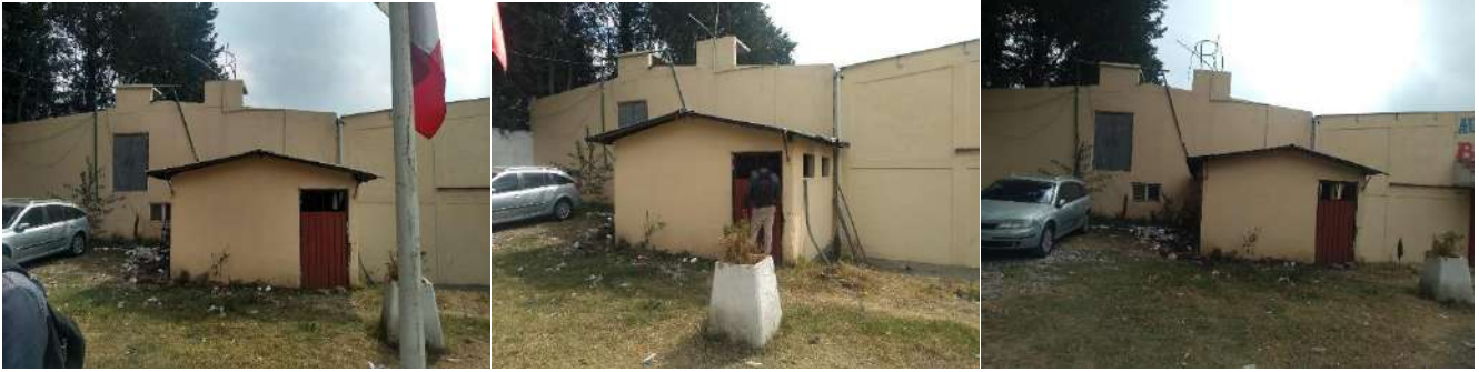
Estas fotografías muestran las condiciones previas a la adaptación de diseño desde una primera imagen de fachada. Fotos de Luis Leonardo
