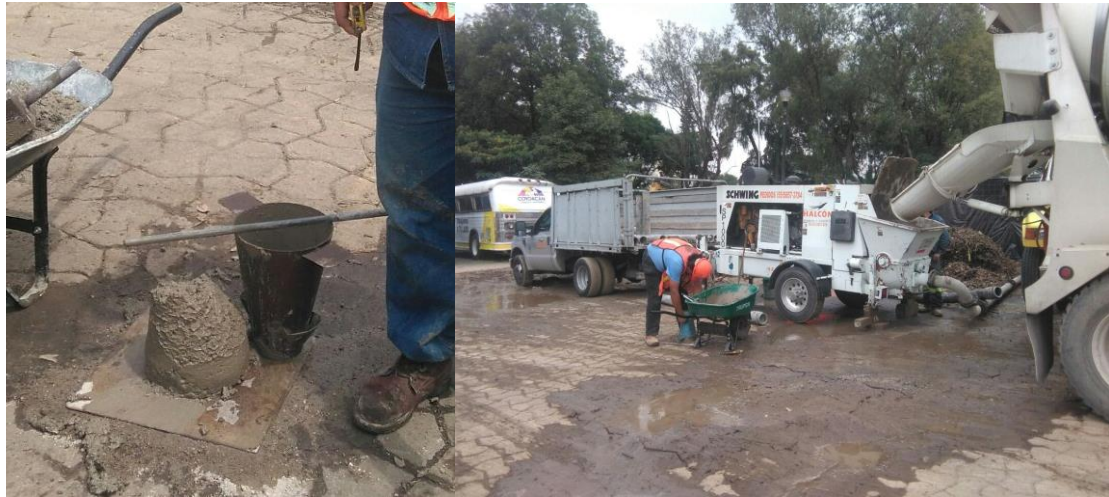
Imagen 3.- Prueba de resistencia de concreto en la obra del CESAC
