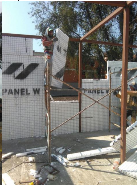
Imagen 12.- Colocación de panel W en clínica geriátrica
