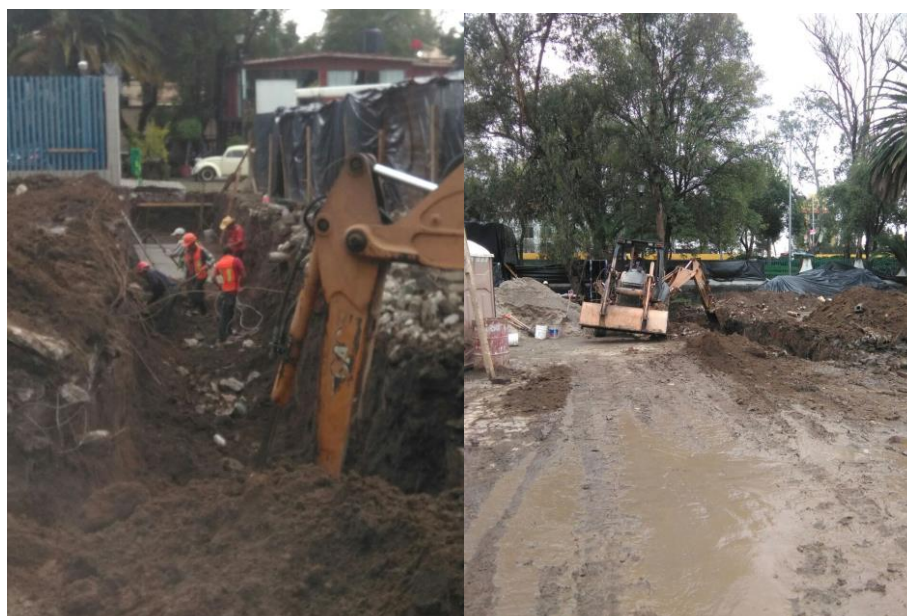
Imagen 2.- Excavación en obra CESAC
