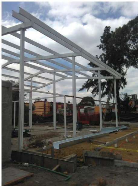
Imagen 11.- Estructura de acero de clínica geriátrica
