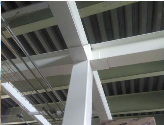
Imagen 9.- Refuerzo en uniones de las vigas de acero en territorial taxqueña
