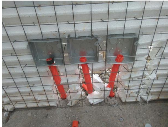
Imagen 15.- Instalación eléctrica en clínica geriátrica
