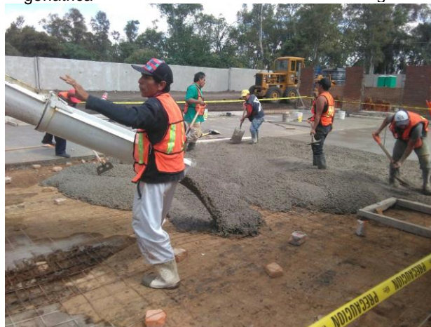
Imagen 13.- Colado para pavimento de clínica geriátrica
