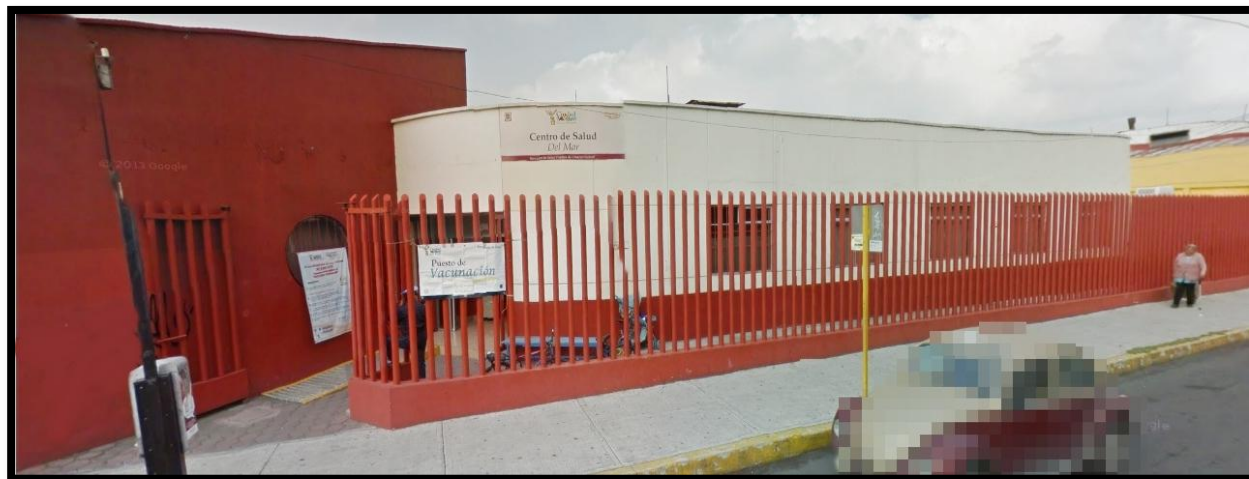
Imagen 1. Fachada del Centro de Salud TII Del Mar
