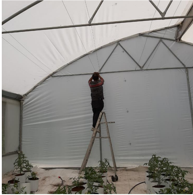
Figura 4. Instalación del sistema de carga. Fuente: Elaboración propia.
