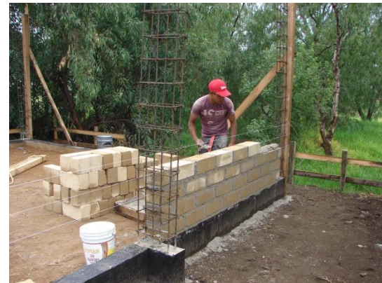
Levantamiento de muro con bloques elaborados en el Laboratorio
