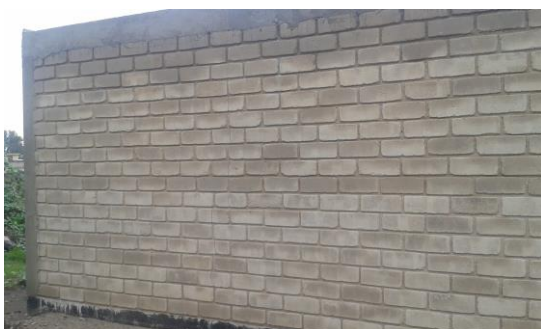
Actualmente se encuentra así los perimetrales
