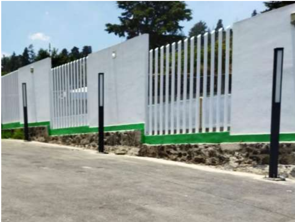
Imagen 2: Exterior de kínder San Pablo Oztotepec, foto propia, 2022
