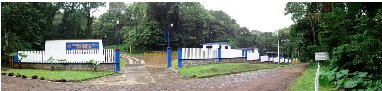
Fig 1. Fachada de la entrada a la estación (IBUNAM, 2024)
