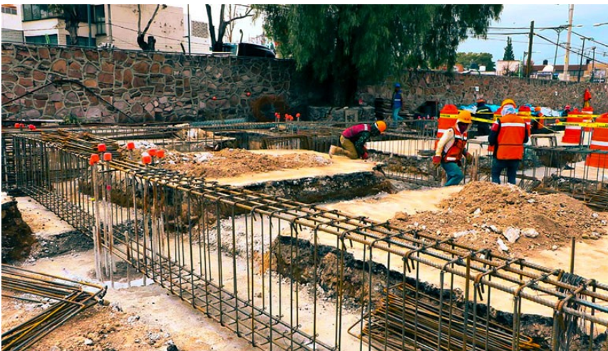
8.-Fotografía de fuente propia. Obra pública realizada en el municipio de Ixtapaluca, Edo. Mex. Año 2021. "Armado de zapatas".
