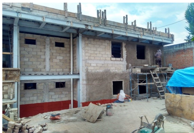
2.-Fotografía de fuente propia. Obra pública realizada en el municipio de Ixtapaluca, Edo. Mex. Año 2021.
