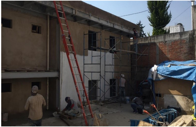
3.-Fotografía de fuente propia. Obra pública realizada en el municipio de Ixtapaluca, Edo. Mex. Año 2021.
