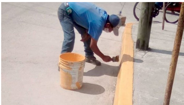
5.-Fotografía de fuente propia. Obra pública realizada en el municipio de Ixtapaluca, Edo. Mex. Año 2021. "Reparación y colocación de guarniciones".
