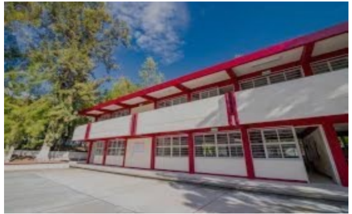
4.-Fotografía de fuente propia. Obra pública realizada en el municipio de Ixtapaluca, Edo. Mex. Año 2021
