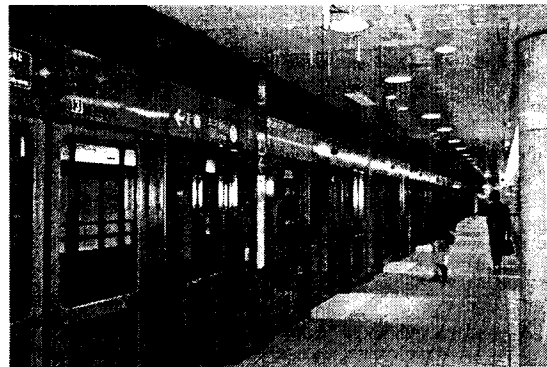
Mamparas de seguridad en el metro de Tokio
