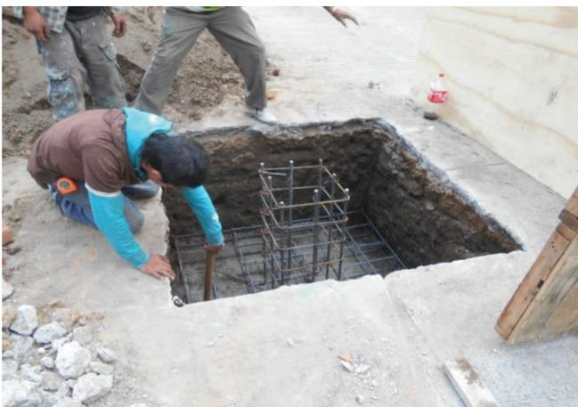
COLOCACIÓN DE ARMADO PARA LA ESCALERA DE EMERGENCIA"
