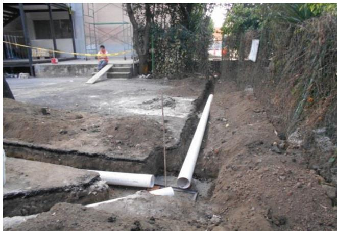
COLOCACIÓN DE TUBO DE PVC PARA DRENAJE
