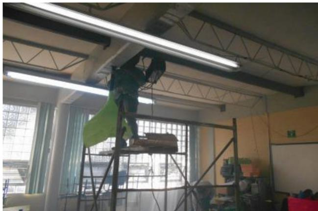
COLOCACIÓN DE MONTEN COMO REFUERZO EN LOSA DE AULA
