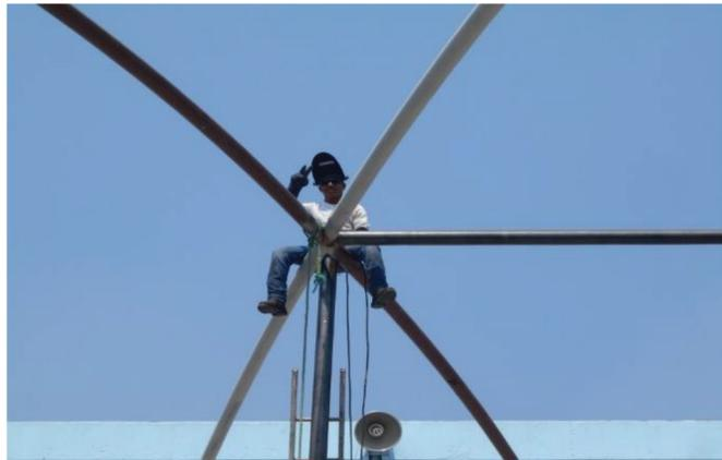
APLICACIÓN DE SOLDADURA EN ESTRUCTURA PARA MEMBRANA ARQUITECTÓNICA
