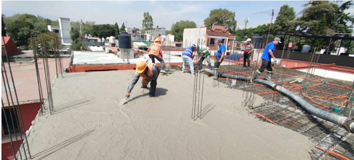
Fig. 6. Al ser aprobado el habilitado de acero, cimbrado e instalación de manguera corrugada así como cajas registro para la posterior instalación eléctrica se procede a colar la losa, normalmente el asesor está presente al momento del colado (fuente propia).
