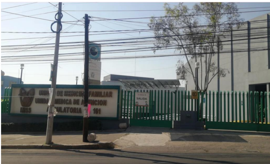
Imagen 16. FACHADA PRINCIPAL DEL LA UMF 161 DEL IMSS
