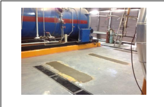
FOTO 3.- TRABAJOS DE ALBAÑILERIA-RESANE EN PISOS CASA DE MAQUINAS.
