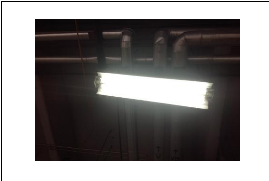
FOTO 5.- I.E.-RECOLOCACION DE LUMINARIAS.
