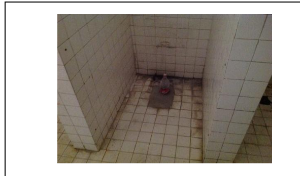
FOTO 2.- TRABAJOS DE ALBAÑILERIA - RESANE EN BAÑOS PARA COLOCACION DE W.C.
