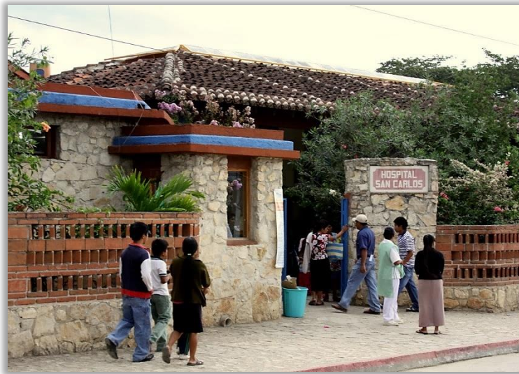
Imagen 1 Hospital San Carlos, Altamirano
