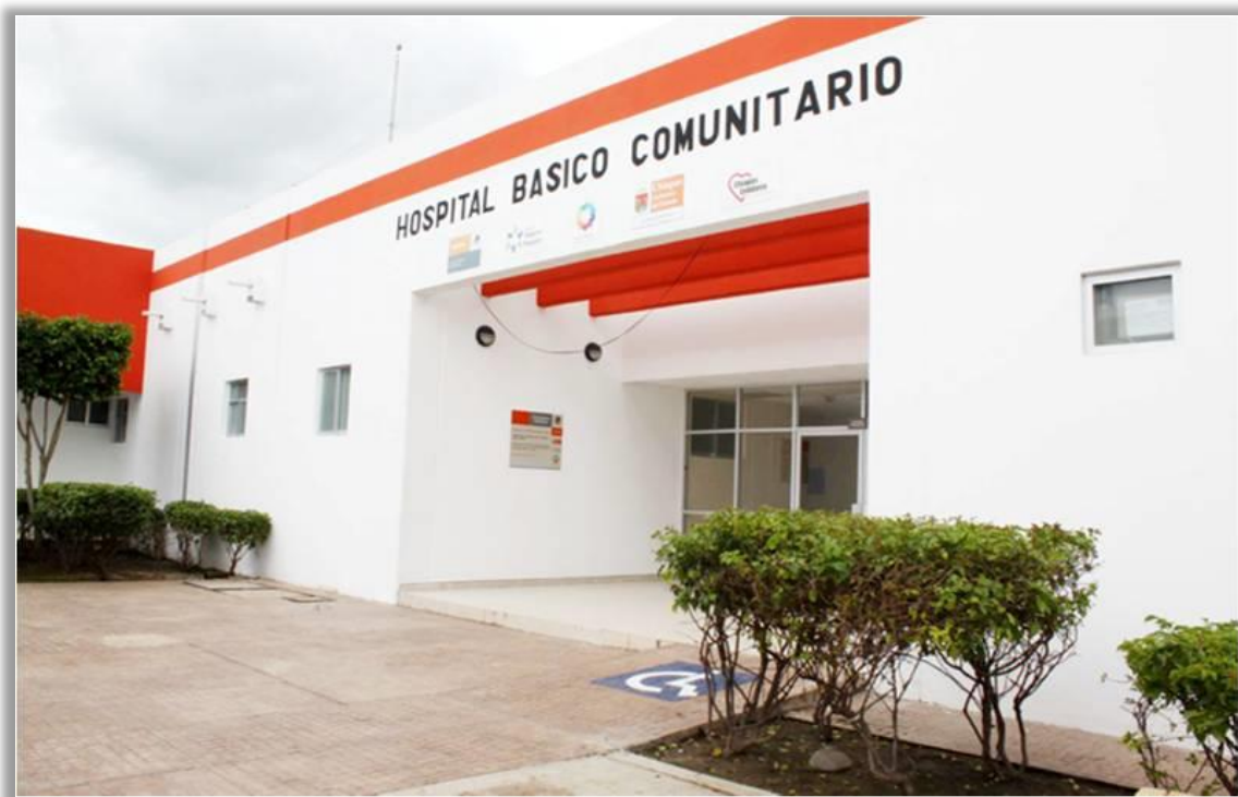
Foto 29 Hospital Básico Comunitario "20 camas" de Ocosingo
