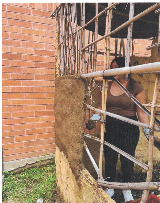
IMAGEN 11 – Aplicación del bajareque en muros del orquidiario
