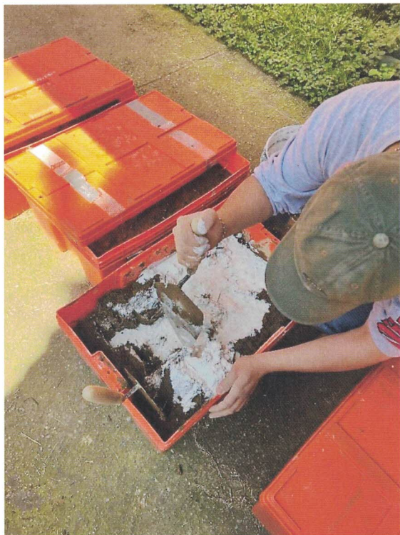
IMAGEN 9 – Preparación de bajareque con cal
