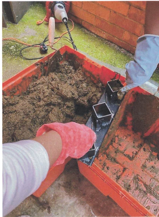
IMAGEN 10 – Toma de muestras para prueba de compresión
