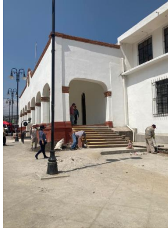
Figura 50. Reconstrucción de escaleras y rodapié en Fachada. [Fotografía]. Fuente: Casiano, D. (2023).
