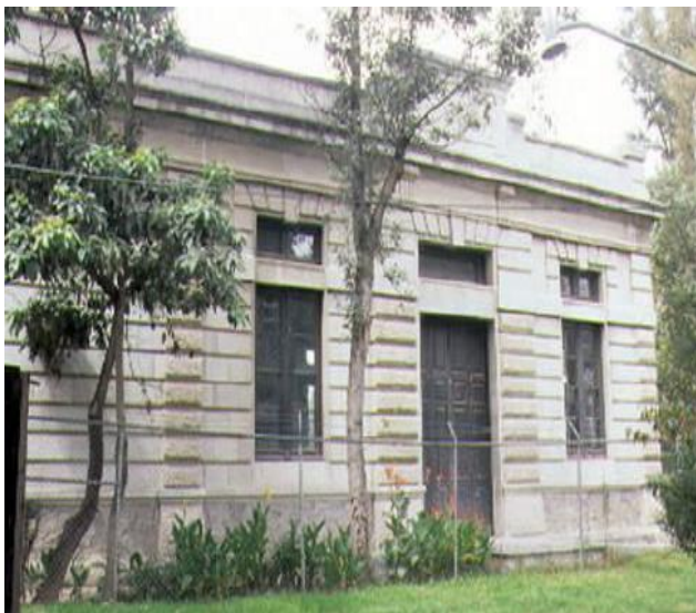
Figura 54. Fachada principal de la Antigua Casa de Bombas No.5. [Fotografía]. INAH. (s.f.). https://catalogonacionalmhi.inah.gob.mx/consultaPublica
