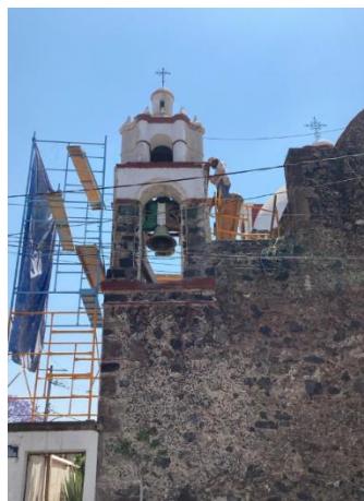
Figura 20. Torre campanario de la Capilla durante los trabajos. [Fotografía]. Fuente: Casiano, D. (2023).
