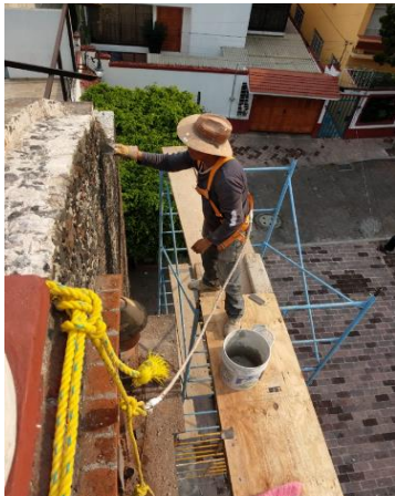
Figura 25. Trabajos de restauración de fachada. [Fotografía]. Fuente: Hernández, S. (2023).
