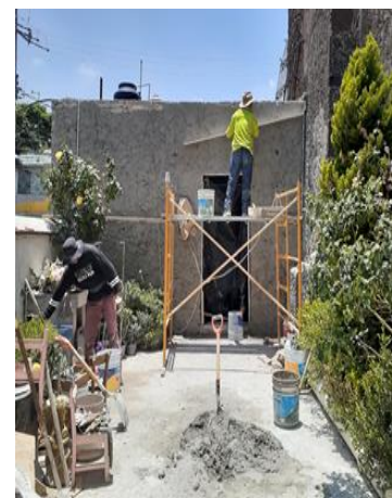
Figura 21. Restauración de la sacristía de la Capilla de San Cristóbal. [Fotografía]. Fuente: Hernández, S. (2023).
