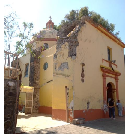
Figura 3. Vista lateral. Restos de la torre campanario. [Fotografía]. Fuente: Casiano, D. (2023).
