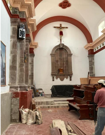
Figura 26. Presbiterio de la Capilla. [Fotografía]. Fuente: Casiano, D. (2023).
