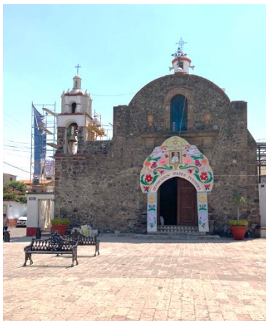
Figura 18. Fachada de la Capilla de San Cristóbal durante los trabajos. [Fotografía]. Fuente: Casiano, D. (2023).
