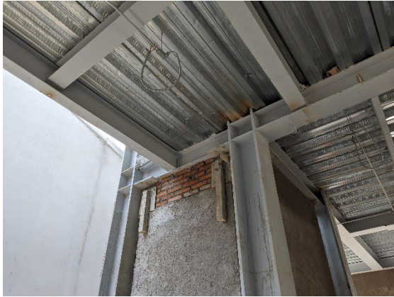
Fig. 14. Visita y supervisión de obra del edificio de Dirección de Concentración Social
