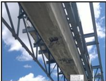
Fotografía 12: Puente de maniobras (vista inferior).
