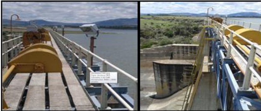
Fotografía 10: Puente de maniobras (vista superior).
