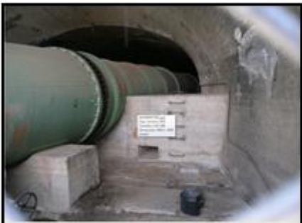
Fotografía 8: Túnel de la tubería a presión.
