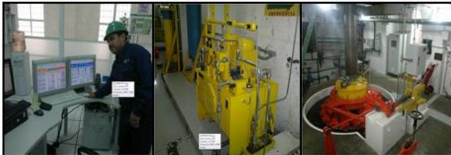
Fotografía 3: Control de la central.
