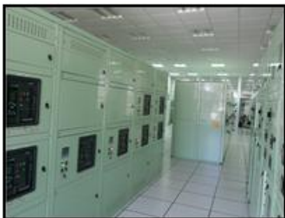
Fotografía 4: Modernización de los equipos de control.
