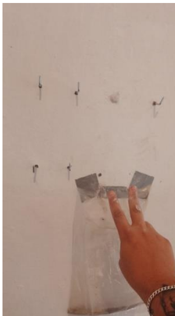
Figura 7: Análisis del área a restaurar con cemento.
