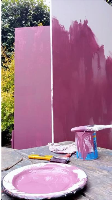
Figura 5: Aplicación de pintura en las mamparas.
