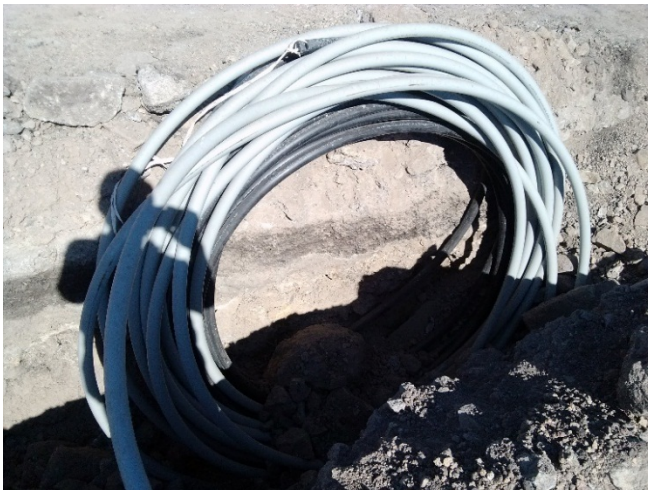
Cableado de luz por suelo
