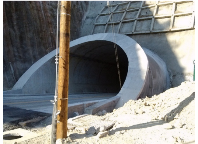
Postes de luz y portal de entrada
