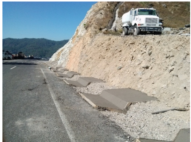
Aramado de drenaje y guarnicion
