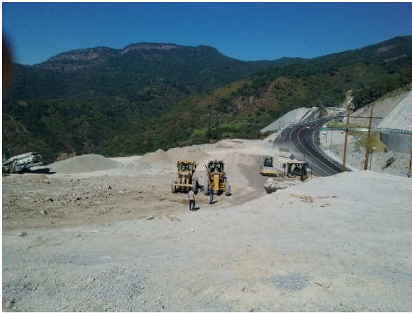
Preparacion de terraceria para cpas asfalticas
