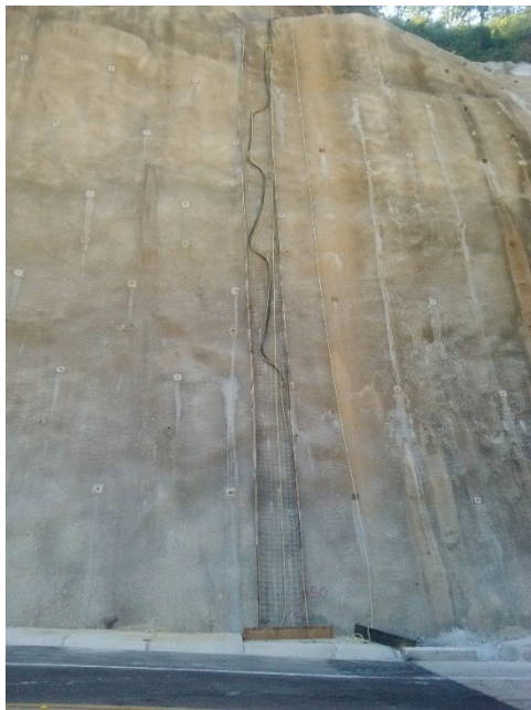
Imagen 3 armado de baja de agua
