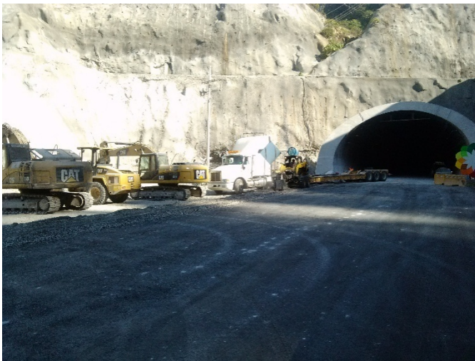
Entrada portal de tunel
