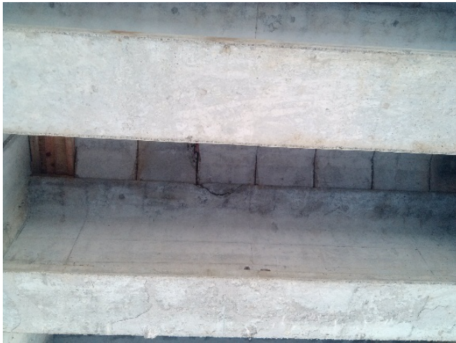
Traveses de puente
