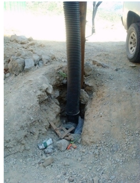
Imagen 4 conexión de poste eléctrico
