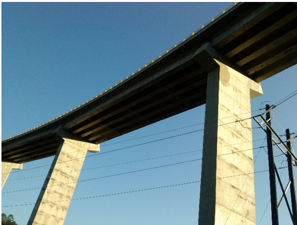
Imagen 2 puente doble voladizo
