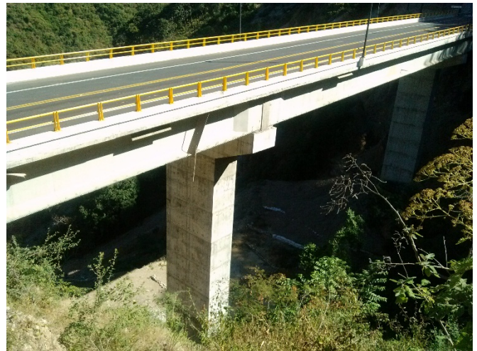
Columana de puentes y parapetos
