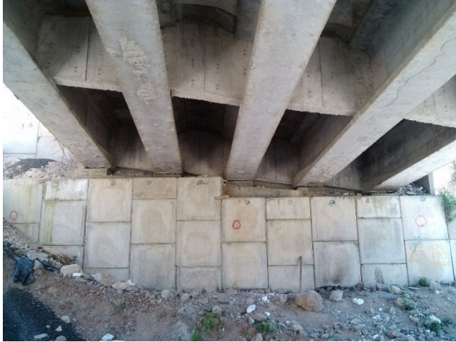
Transición de puente y carretera
