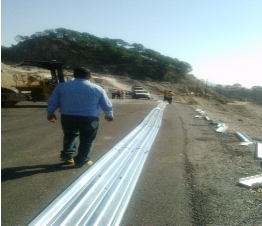
Cuantificacion de parapeto piezas colocadas
