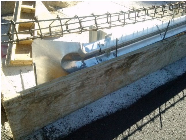
Volumen de concreto para colocacion de parapeto
