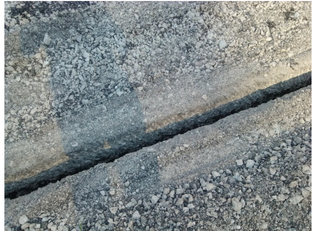
Imagen 2 ranura para cableado de fibra óptica para túnel
