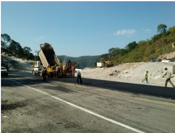
Colocacion de capas de impregnacion
