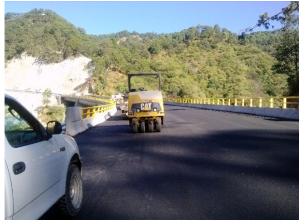
Terminado de cpas asfalticas
