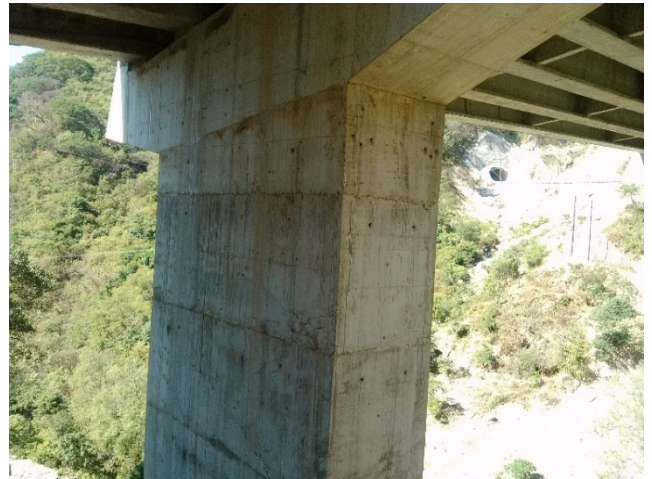
Imagen 3 columna de puente
