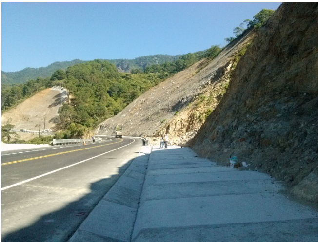
Terminado de drenajes y guarnicion
