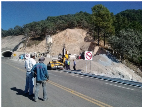
Colocacion de parapeto
