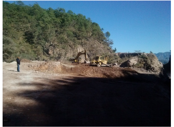
Imagen 2 movimiento de arena para entronque de carretera.
