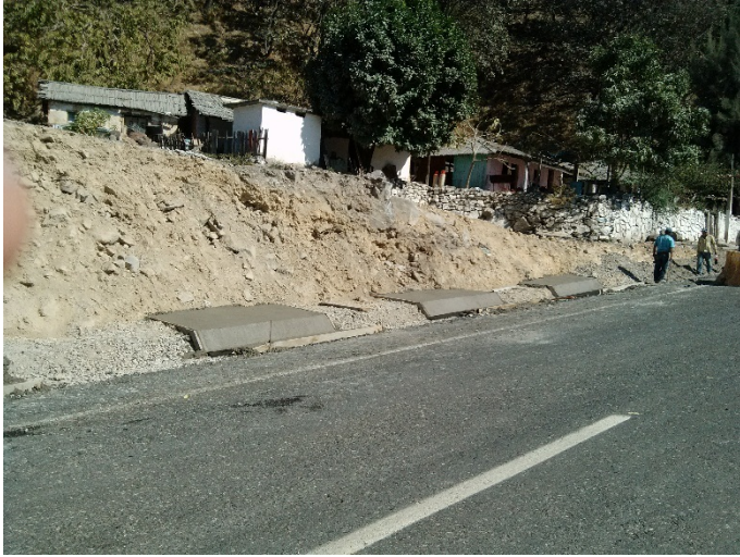
Imagen 1 armado de drenaje
