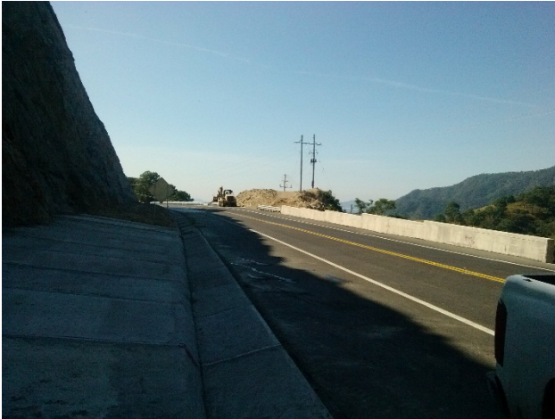
Drenaje y acotamiento de carretera
