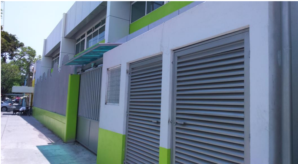
Terminado final de la fachada Foto por el autor.
