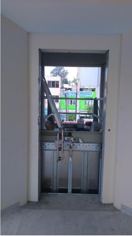
Instalación del ascensor Foto por el autor.
