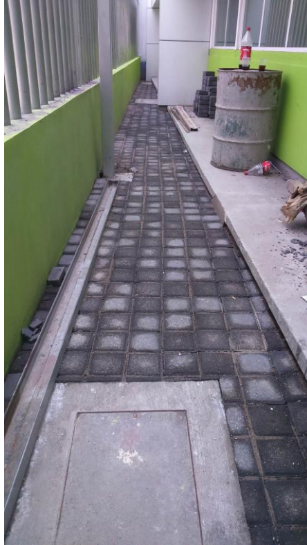
Colocación de adoquín Foto por el autor.
