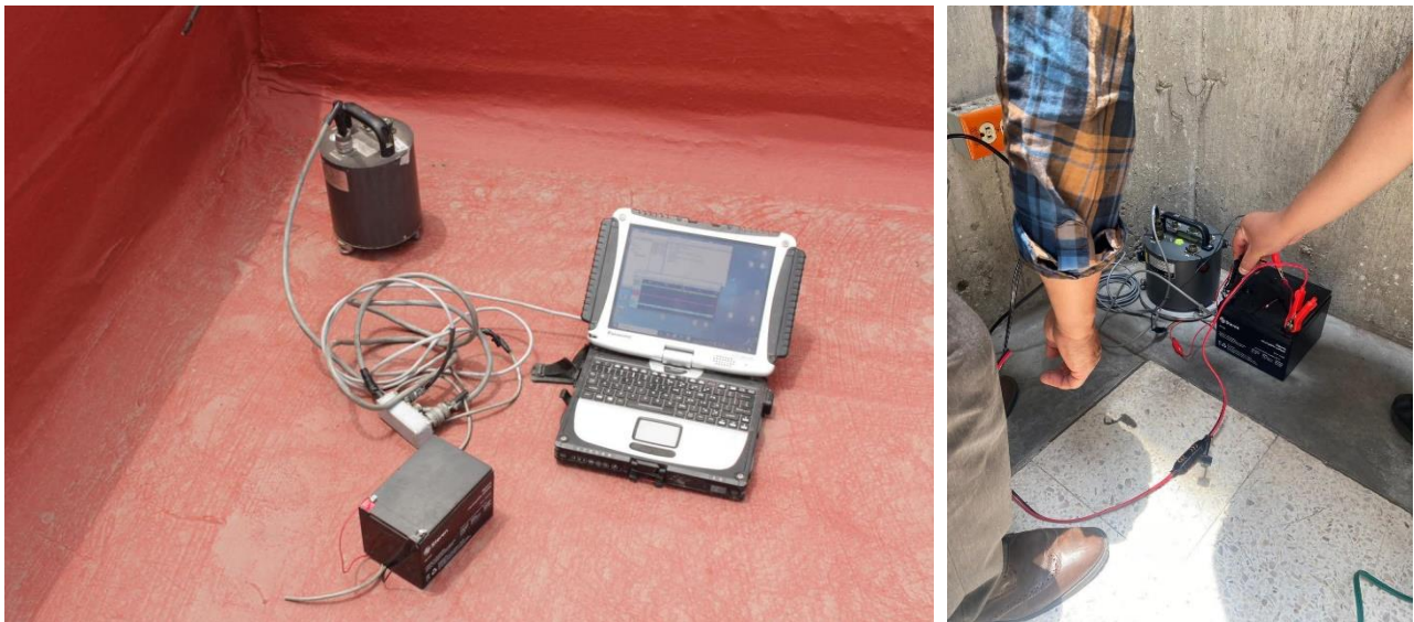
Figura 1 y 2. Instalación de Acelerógrafos.
