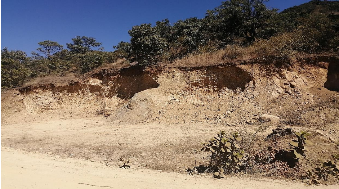
Imagen 7. Actividades realizadas para ampliación de camino.
