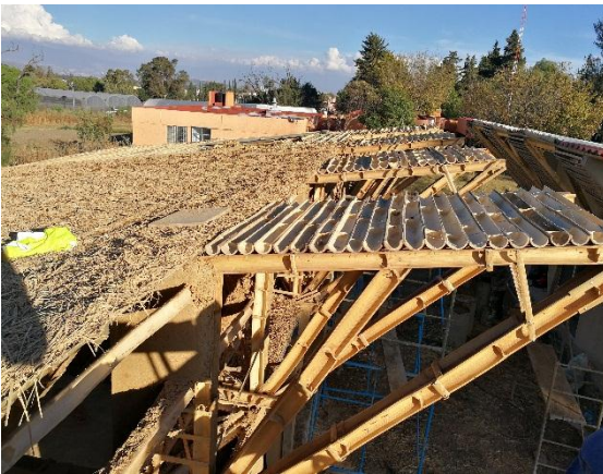
Fotografía 31.6: Proceso de montaje de la cubierta
