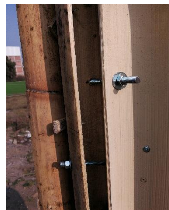
Fotografía 19: Unión entre los muros
