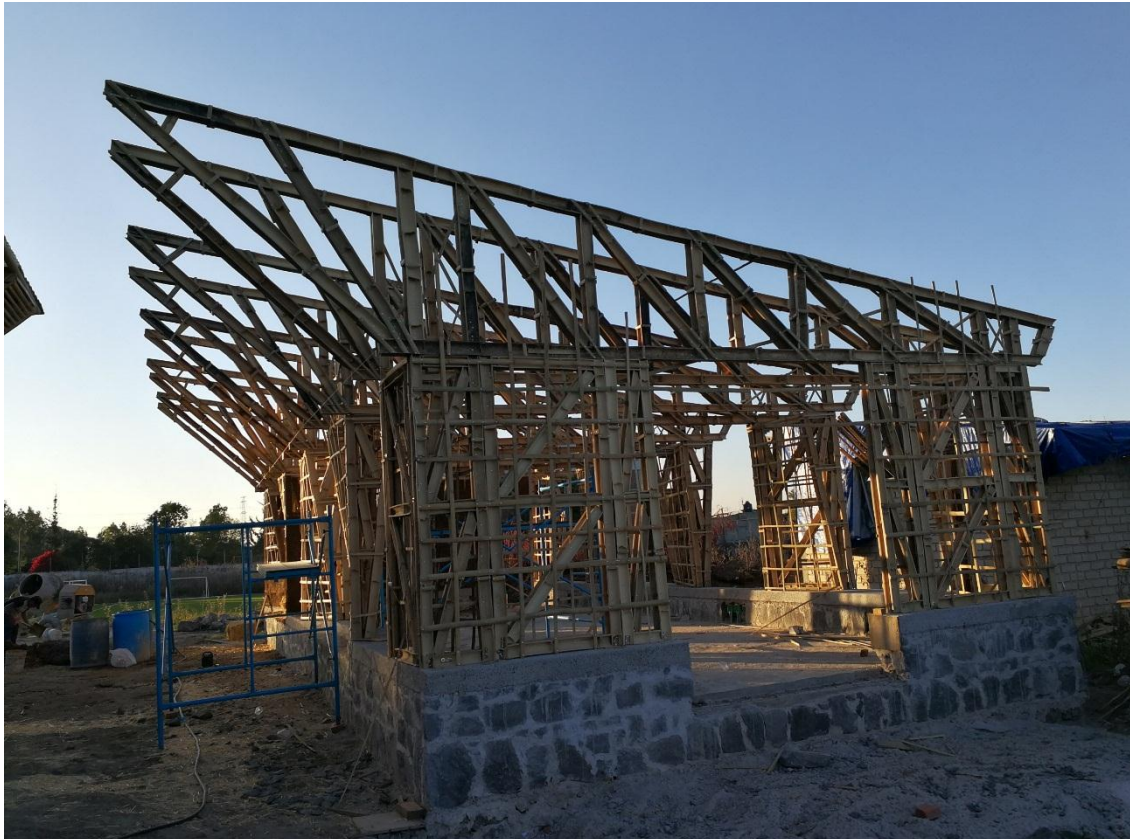
Fotografía 26: Elementos estructurales de bambú montados y fijados
