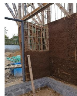
Fotografía 29.2: Proceso de construcción de los muros
