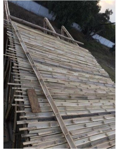
Fotografía 31.3: Proceso de montaje de la cubierta
