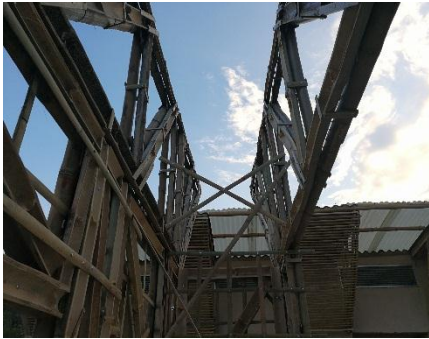
Fotografía 20.1: Montaje de las armaduras de soporte de la cubierta
