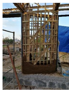
Fotografía 29.1: Proceso de construcción de los muros
