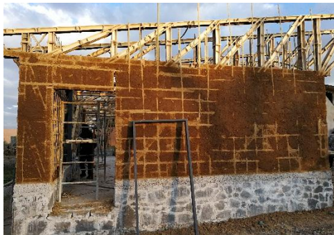
Fotografía 29.3: Proceso de construcción de los muros
