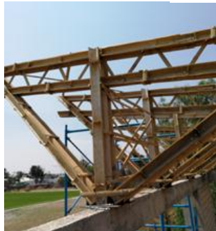
Fotografía 4: Colocación de refuerzos diagonales
