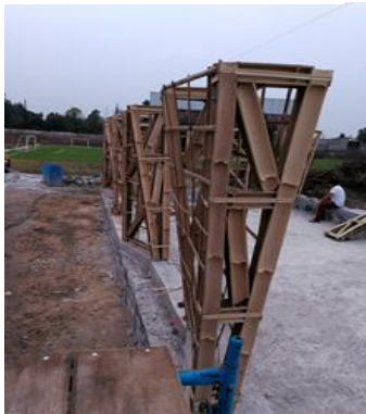
Fotografía 15: Montaje de los muros
