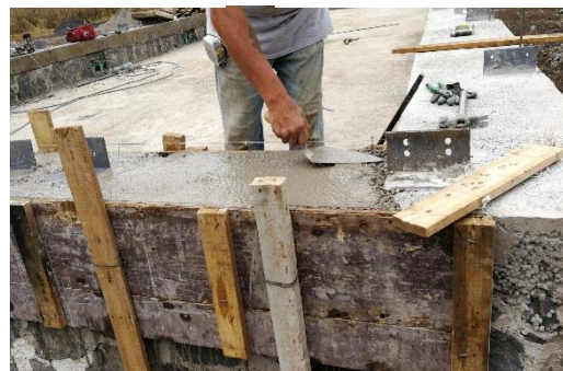
Fotografía 9.2: Colocación de las placas de anclaje en la cadena de desplante del muro
