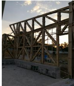
Fotografía 20.2: Montaje de las armaduras de soporte de la cubierta
