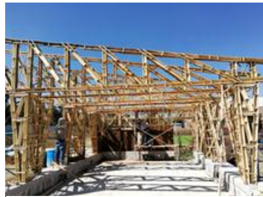
Fotografía 24: Elementos estructurales de bambú montados y fijados
