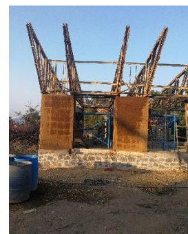
Fotografía 30.2: Repellado de los muros
