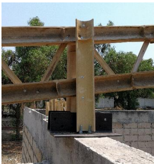
Fotografía 3: Montaje y fijación de la armadura plana
