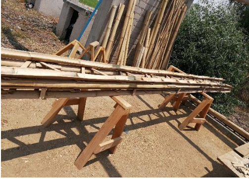
Fotografía 1: Armadura tipo Warren plana
