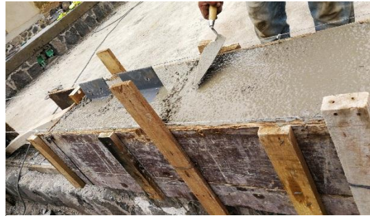
Fotografía 11: Alineación de las placas de anclaje del módulo de muro
