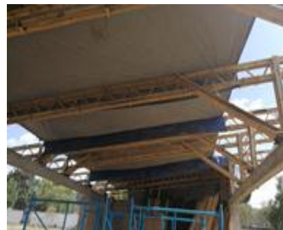
Fotografía 5: Protección de las Armaduras con lonas
