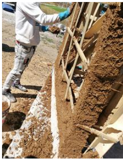
Fotografía 27: Relleno de los muros
