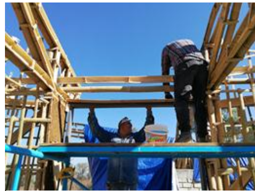
Fotografía 22: Colocación de los PTR y los marcos de las ventanas
