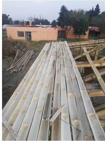
Fotografía 31.2: Proceso de montaje de la cubierta
