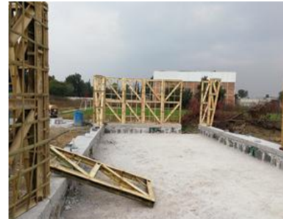
Fotografía 14: Presentación de los muros
