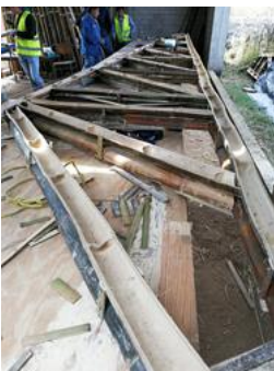
Fotografía 8.2: Armadura de soporte de la cubierta
