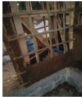
Fotografía 28: Colocación de la paja
