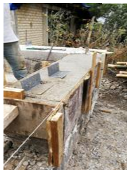
Fotografía 9.1: Colocación de las placas de anclaje en la cadena de desplante del muro
