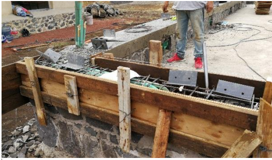
Fotografía 10: Colado de una sección de la cadena de desplante del muro
