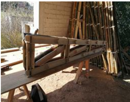
Fotografía 6: Primer módulo estructural del muro
