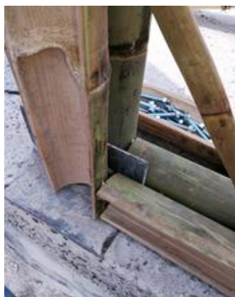
Fotografía 18: Sistema de fijación de los muros continuos
