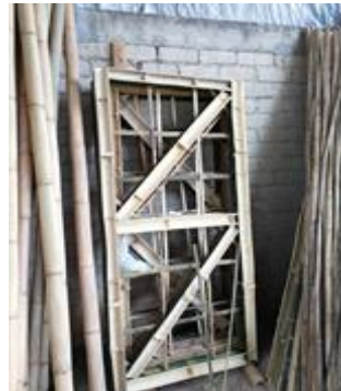
Fotografía 7: Segundo módulo estructural del muro
