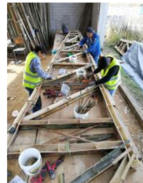
Fotografía 8.1: Armadura de soporte de la cubierta
