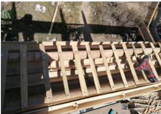
Fotografía 23: Marcos de las ventanas
