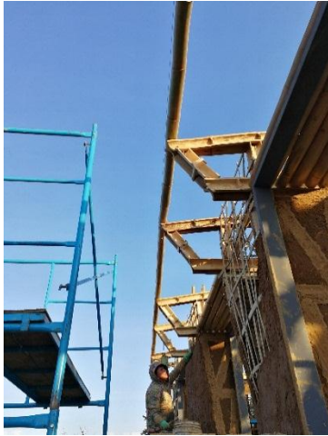
Fotografía 31.1: Proceso de montaje de la cubierta
