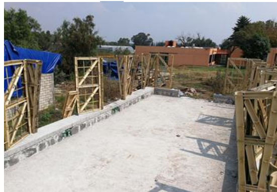
Fotografía 16: Zonificación de los muros ya fijados
