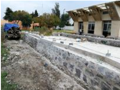
Fotografía 12: Cimentación y cadena de desplante con placas de anclaje
