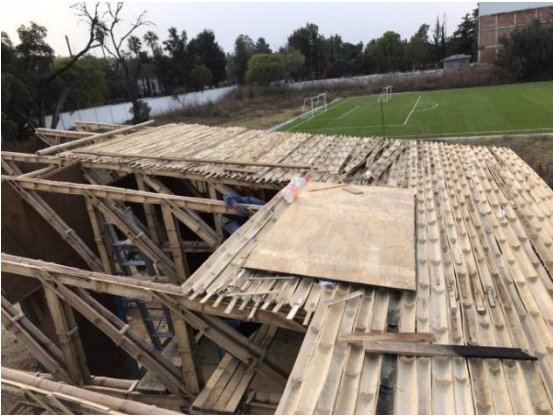
Fotografía 31.4: Proceso de montaje de la cubierta
