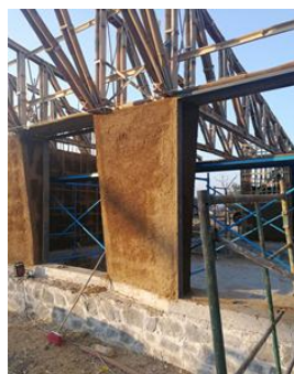
Fotografía 30.1: Repellado de los muros
