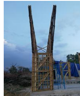
Fotografía 20.3: Montaje de las armaduras de soporte de la cubierta
