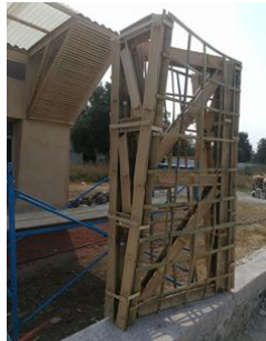
Fotografía 13: Ensamblaje del muro
