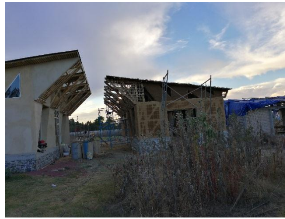
Fotografía 32: Montaje de la cubierta terminado
