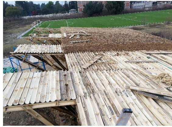
Fotografía 31.5: Proceso de montaje de la cubierta
