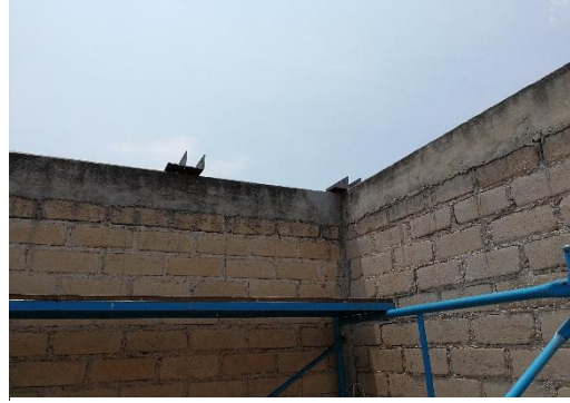
Fotografía 2: Colocación de las placas de anclaje en la cadena de cerramiento
