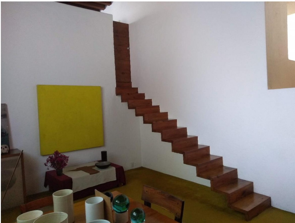
Escalera de madera empotrada. Foto: Manuel Medina.
